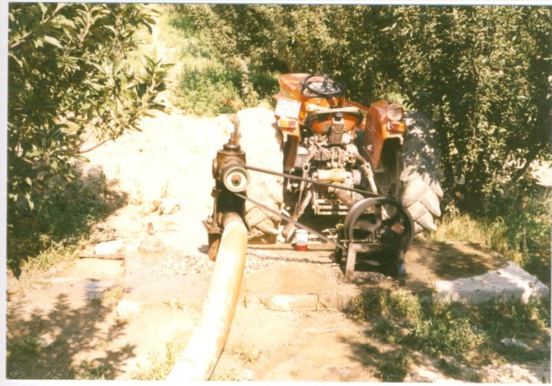
Foto 6.2a. Eymir kuyusunda pompa testi yapılmaktadır
