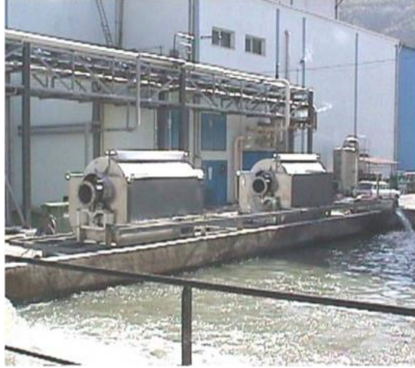
Şekil 7.3. Mekanik filtrasyonda kullanılan tambur filtre (Anonim 2011a)
