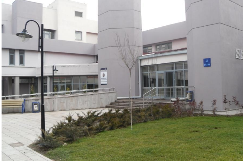
Şekil 4: J blok ve rampadan bir görünüm
