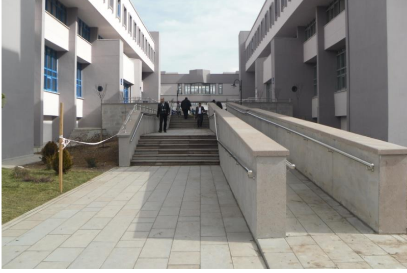
Şekil 8: Alandaki rampa ve merdivenden bir görünüm
