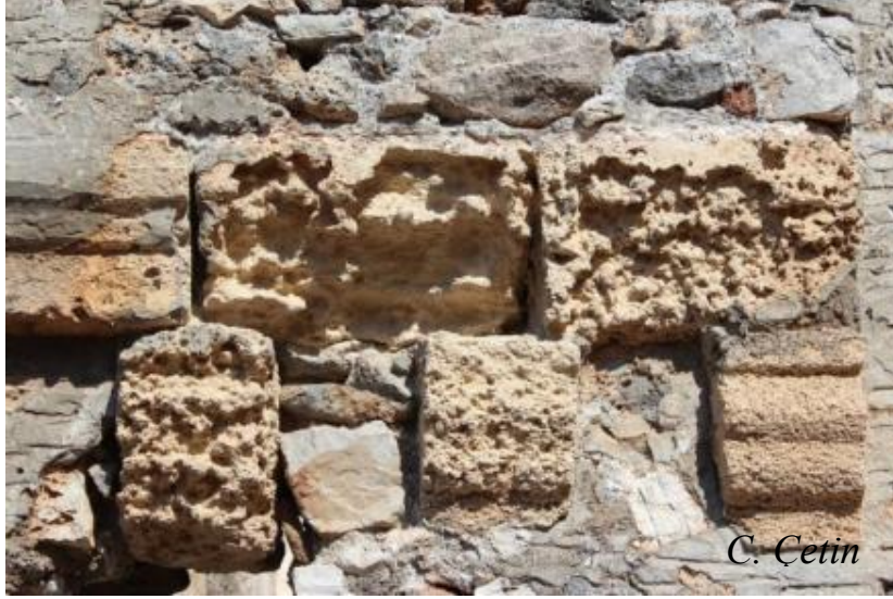
Resim 17. Karmylissos'da bir evin konsollarında petek gözlülük, Fethiye 2013, (C. Çetin)
