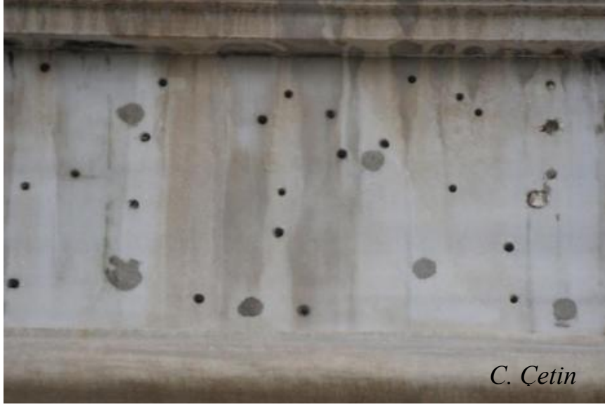
Resim 9. Darphane kapısındaki mermer yapı elemanlarına tabela asmak için matkapla açılmış delikler, İstanbul 2015 (C. Çetin):
