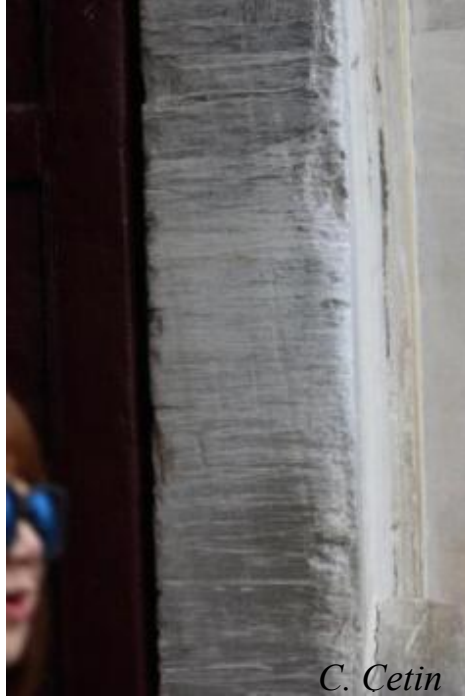
Resim 13. Topkapı Sarayı dış surlardaki girişte motorlu araç faaliyetleri sonucunda oluşmuş çizikler, İstanbul 2015 (C. Çetin)
