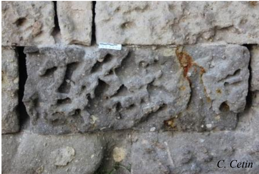
Resim 18. Konstantin Helen Kilisesi duvar bloklarında petek gözlülük görülmekte, Nevşehir, Mustafa Paşa, 2012 (C. Çetin)
