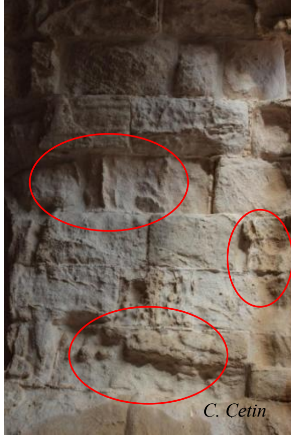
Resim 15. Kasimiye Medresesi'nde Kireçtaşı bloklarla örülmüş duvarda taşın yumuşak bölümleri erozyona uğrarken daha sert belli bölümleri korunmuş, Mardin 2012 (C. Çetin)
