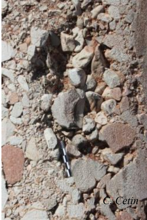
Resim 16. Yeni Camii'nin pudingden yapılmış sütunlarında içerik kaybı görülüyor, İstanbul 2012 (C. Çetin)
