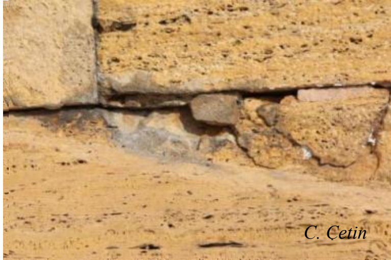
Resim 6. Anıtkabir'de traverten bloklarda yük kayması sonucunda oluşan yongalar, Ankara 2013 (C. Çetin)
