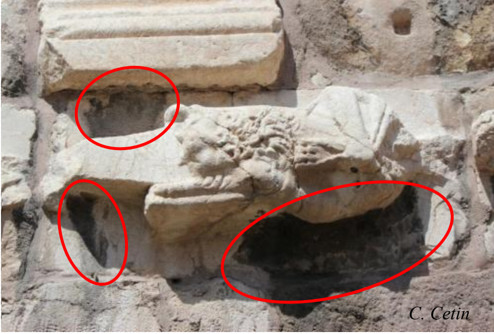
Resim 4. Sur duvarında yatay olarak kullanılmış kabartmanın alt bölümlerinde siyah tabaka oluşumu, Ankara 2014 (C. Çetin).
