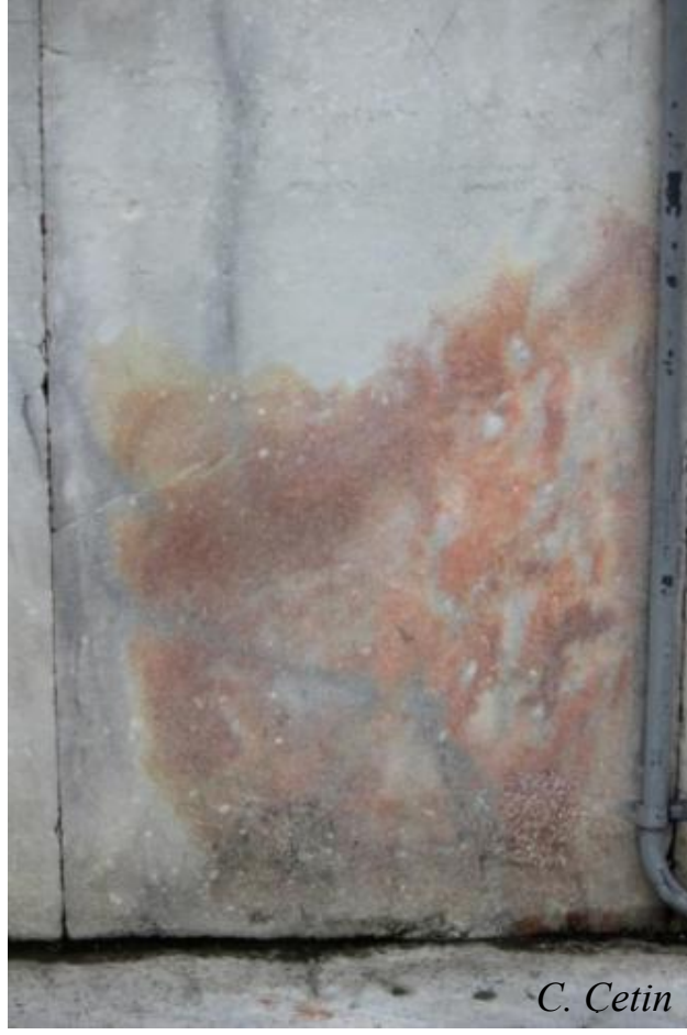
Resim 20. Bir beyaz mermer bloğun bünyesindeki minerallerin oksitlenmesi sonucunda renginin değişmesi, İstanbul, Sultan Ahmet Camii, 2015 (C. Çetin).
