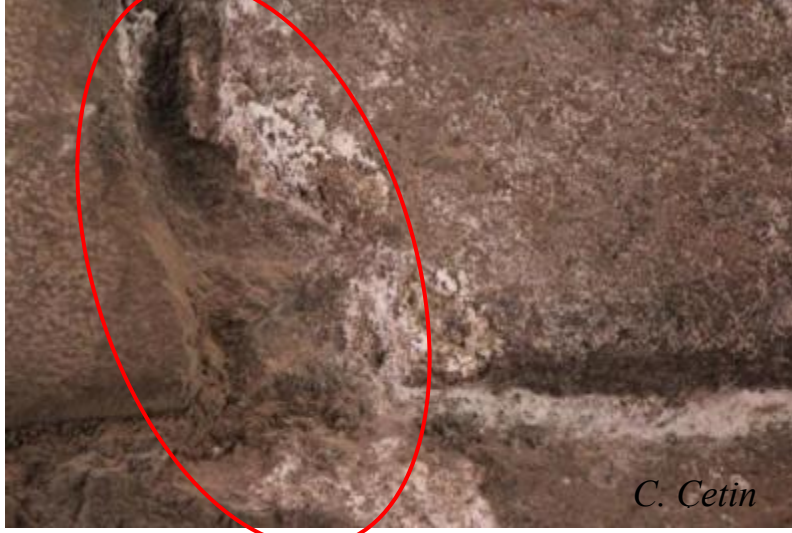
Resim 3. Sur duvarında koyu ve açık renkli tuzlanma, Ankara 2014 (C. Çetin).
