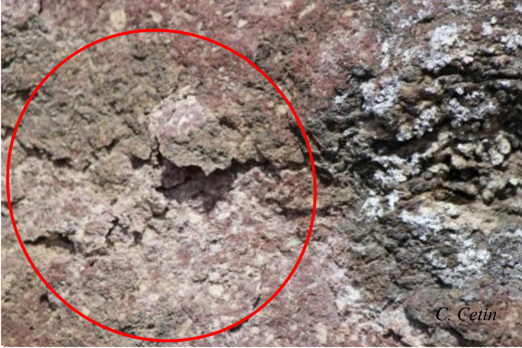
Resim 7. Anezit bir blokta yüzeyin hemen altında meydana gelen kristallenme sonucunda kabarma oluşmuş, Ankara Kalesi 2015 (C. Çetin).
