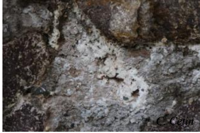
Resim 2. Sur duvar örgüsünde tuzlanma, Ankara 2015 (C. Çetin).
