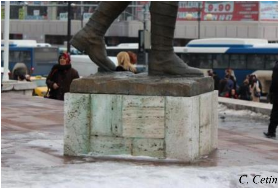
Resim 19. Üzerindeki bronz heykelin korozyonunun üzerine akması sonucunda yeşile boyanmış beyaz traverten bloklar, Ankara, Ulus Zafer Anıtı, 2012 (C. Çetin)
