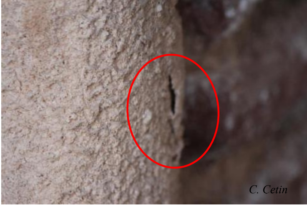
Resim 9. Kireçtaşı bir sütun üzerinde derinde kristalleşme nedeni ile kabarma, Ankara Kalesi 2014 (C. Çetin)
