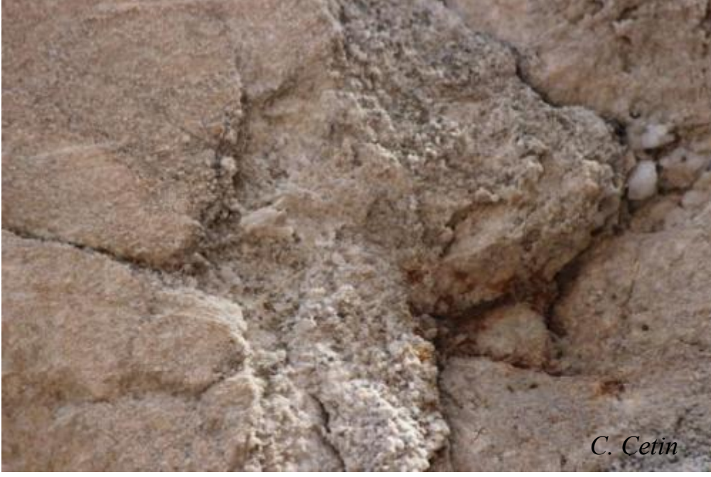
Resim 13. Augustus Tapınağı sella duvarına ait bir blok üzerinde kimyasal bozulma sonucu görülen şekerlenme, Ankara 2015 (C. Çetin)
