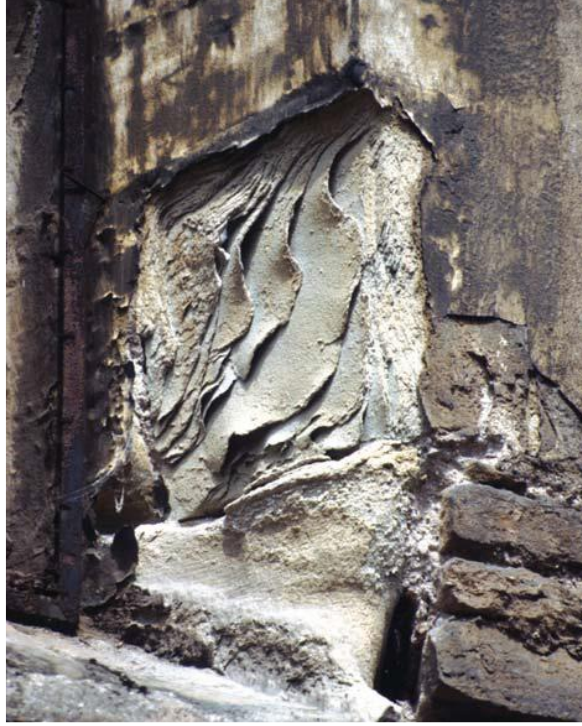
Resim 16. Kumtaşından bloğun yüzeye yakın bölümlerinde yapraklaşma gözlemlenmektedir. Almanya, Zeitz Katedrali, 1992 (Verges-Belmin 2008, 19)
