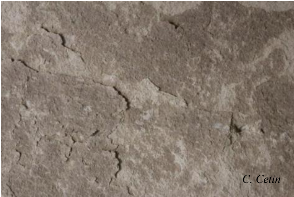
Resim 17. Tüf duvarda yapraklanma, Kapadokya, Aynalı Kilise, 2012 (C. Çetin)
