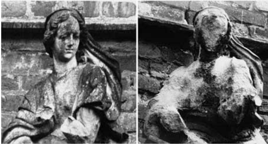
Resim 15. Bir heykelde ufalanma, [http://www.bilmekvar.com/asit-yagmuru-nedir-nedenleri-ve-zararlari-nelerdir (23.05.2015)]
