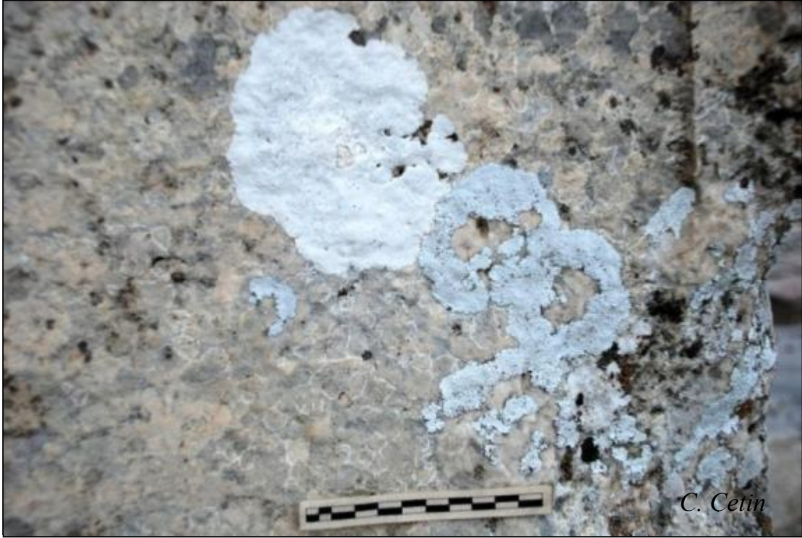
Resim 2. Sagalassos bouleuterionunun kuzey duvarının dış cephesine ait bir mermer blok üzerinde liken kolonizasyonu Burdur , 2011 (C. Çetin)
