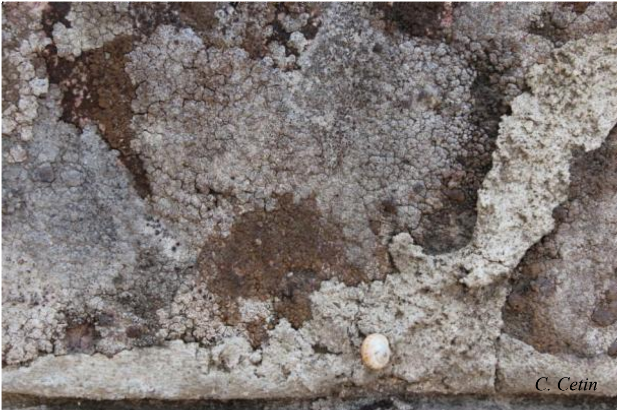
Resim 3. Andezit bir blok üzerinde liken kolonizasyonu, Ankara Üniversitesi Ziraat Fakültesi, 2011 (C. Çetin)
