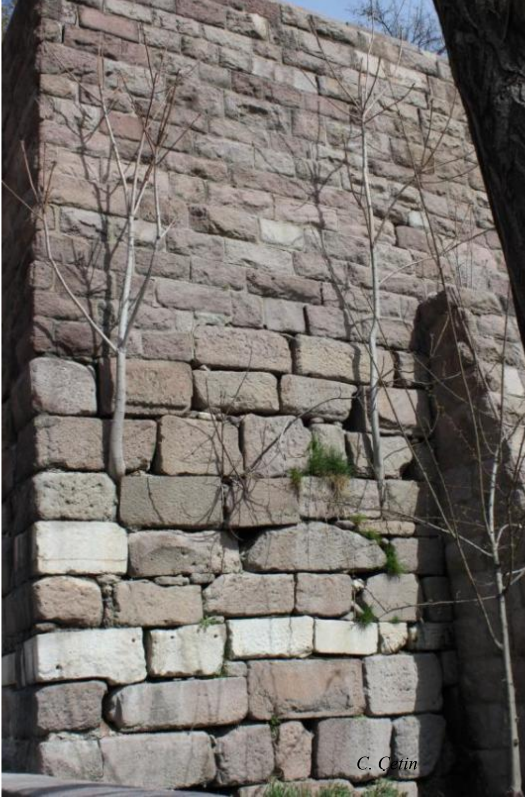
Resim 13. Bir sur duvarının boşalan derzlerinde gelişmiş ağaç ve otlar, Ankara Kalesi, 2015 (C. Çetin)
