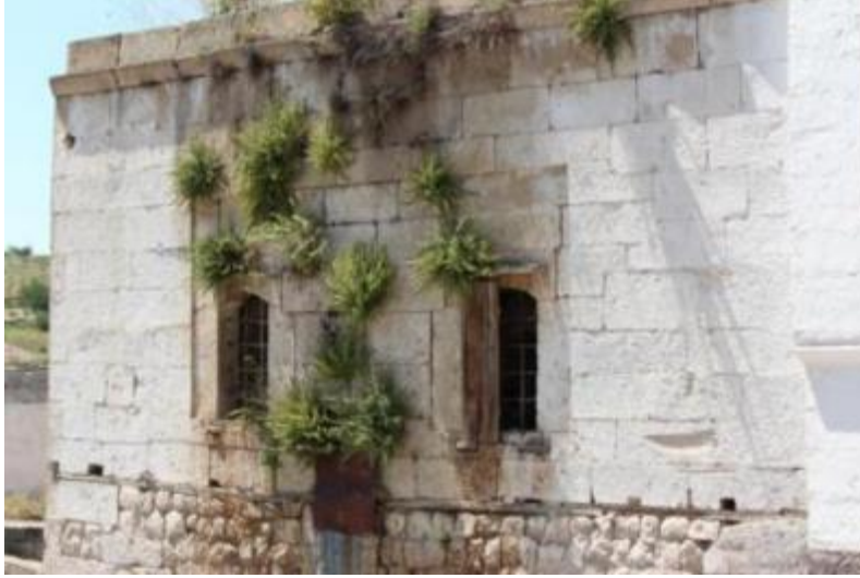
Resim 11. Bir duvar örgüsünde derz boşluklarına yerleşmiş köklü ve yapraklı bitkiler, Ürgüp, Ortahisar, 2012 (C. Çetin)
