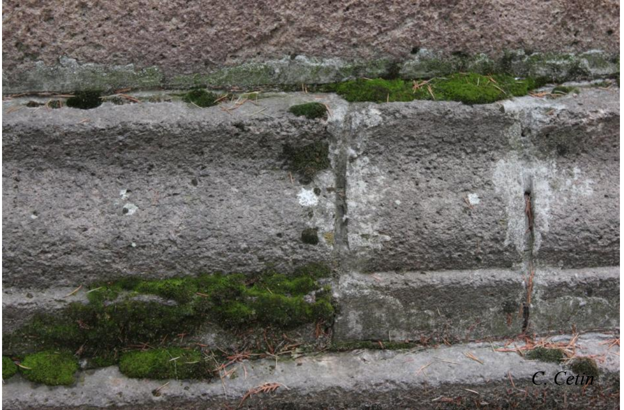
Resim 8. Andezit bloklarla inşa edilmiş bir mezarda yosun kolonizasyonu, Ankara, Cenabı Ahmet Paşa Camii, 2011 (C. Çetin)
