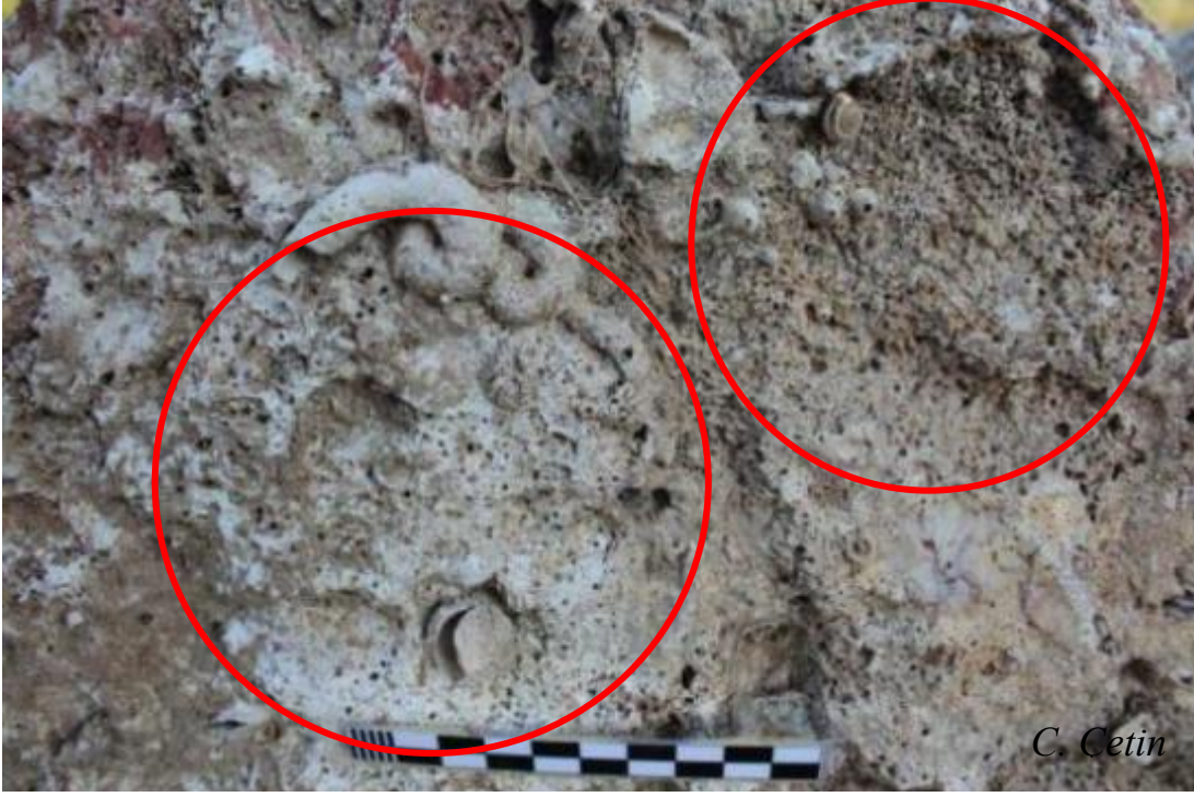
Resim 14. Bir kireçtaşı sütun üzerinde üreyen lithophagous organizmaları taşın yüzeyinde delikler oluşturmuş, Urla 2014 (C. Çetin)
