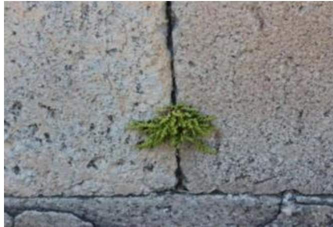
Resim 12. Duvar derzinde yapraklı ve köklü bir bitkinin gelişimi, Erzurum, Lala Mustafa Paşa Camii güney cephe, 2013 (C. Çetin)
