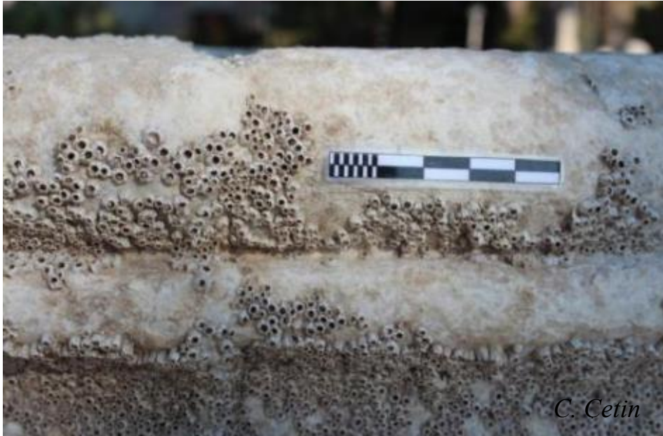
Resim 15. Bir kireçtaşı sütun üzerinde üreyen deniz kabuklularının oluşturduğu kolonizasyon, Urla 2014, (C. Çetin)
