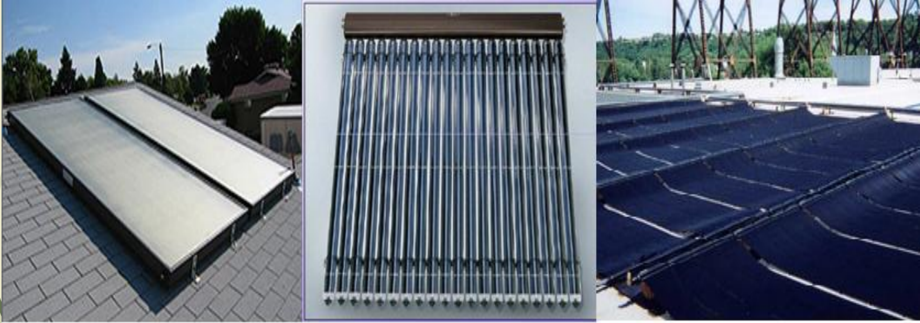
Şekil 4.11 Güneş kolektörü tipleri, a. Düzlemsel güneş kolektörleri, b. Vakum tüplü güneş kolektörleri, c. Camsız güneş kolektörleri (Altuntop ve Erdemir, 2013)
