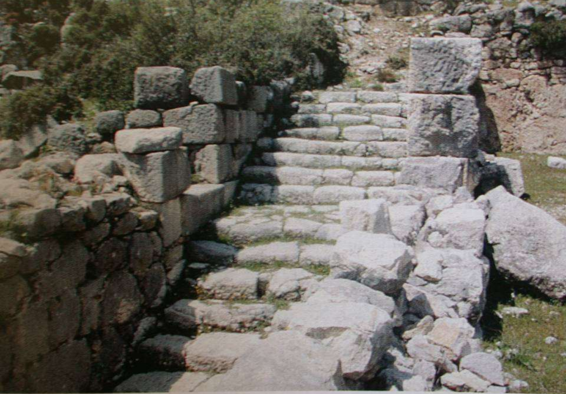
Devlet Agorasi'nın batısındaki merdivenli sokak
