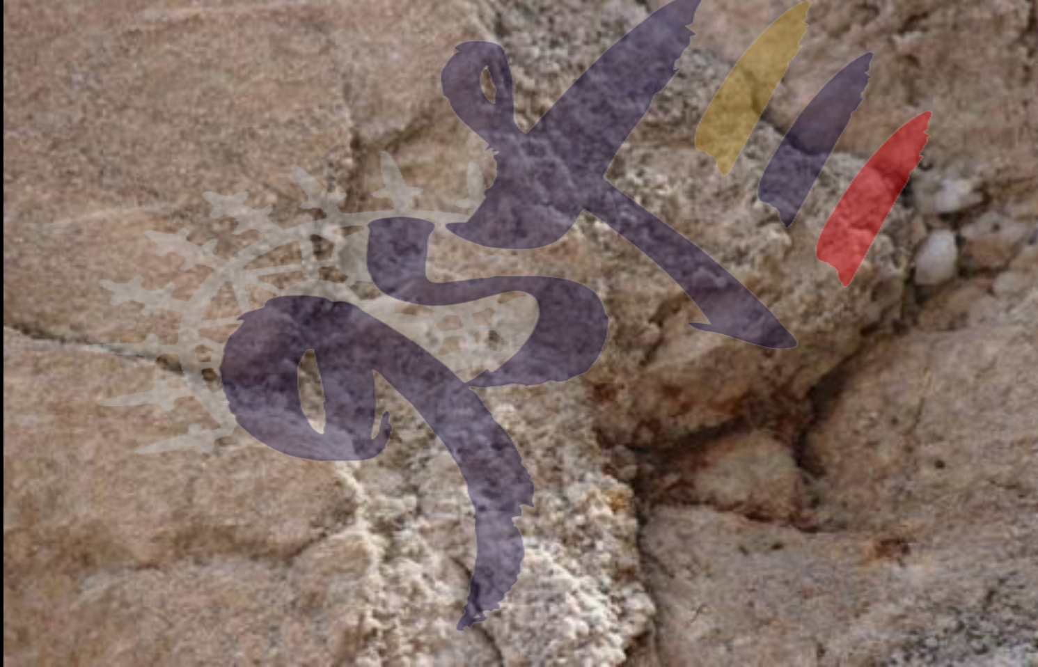
Augustus Tapınağı sella duvarına ait bir blok üzerinde kimyasal bozulma sonucu görülen şekerlenme, Ankara 2015 (C. Çetin
