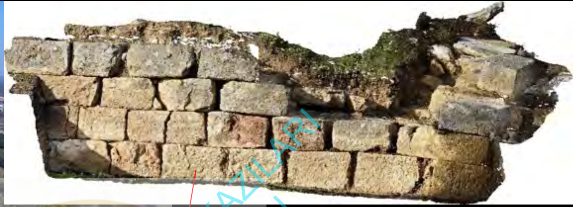
Arkaik Dönem Teras Duvarı
