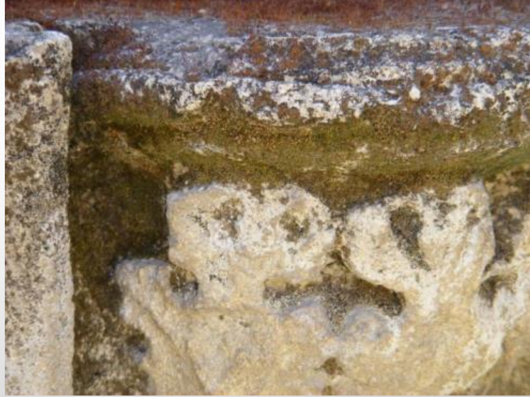
Bir yapı elemanı yüzeyinde liken ve yosun birikimi görülmektedir. (C. Çetin, Lefkoşa 2010)
