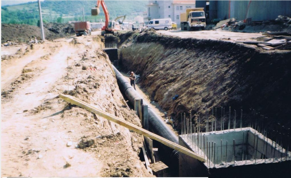
GLCK YENİKY DEPREM KONUTLARI ALTYAPI İŐLERİ.
