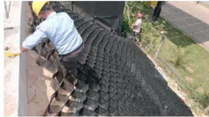
Hücresel Dolgu Sistemi sabitleme uygulaması
