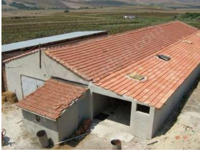
Resim 2.1: Fidanlık işletme binası
