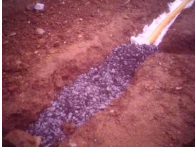
Resim 2.4: Kapalı drenaj sistemi
