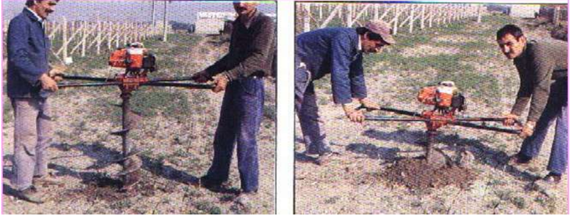
Resim 2.9: Motorlu el burgusu ile fidan çukurlarının açılması
