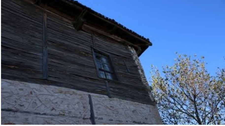
Şekil 7.3. Bir yüzü duvar örgülü tarihi ev
