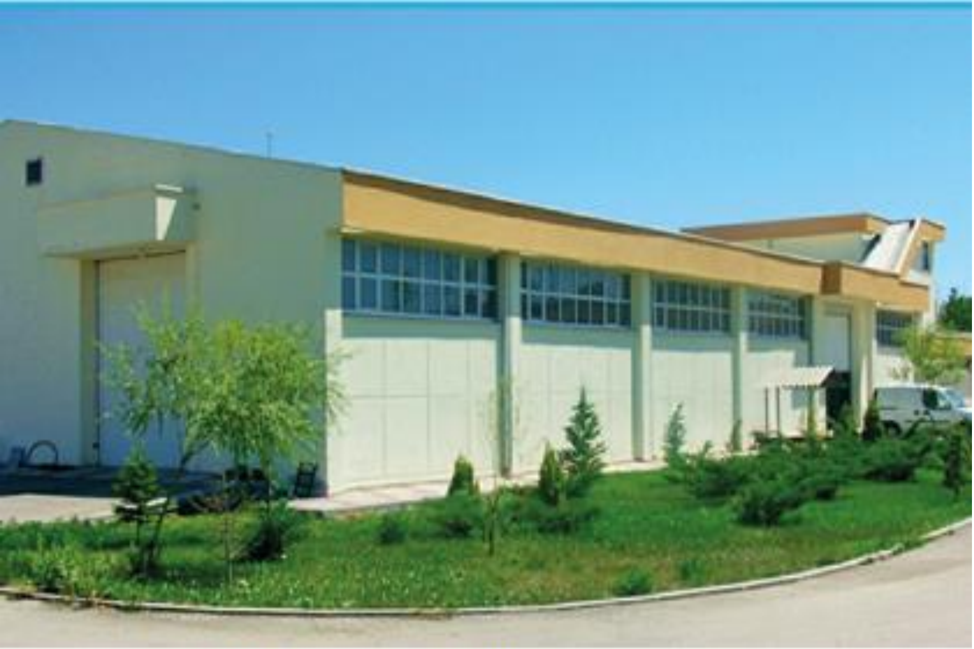
TAEK Gama Işınlama Tesisi
