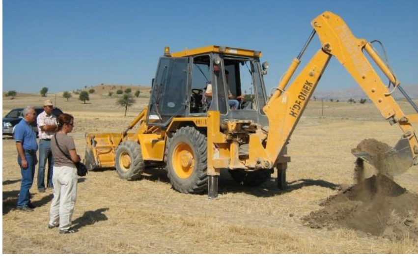
Şekil 1.11. Profil Çukurlarının Beko Aracı İle Kazılması.
