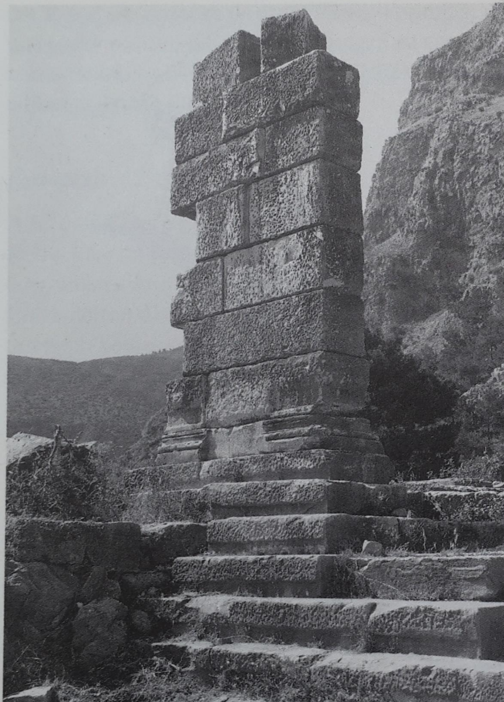
81 Priene, Athenaheiligtum – Propylon: Unfertig belassene Stufen und in Bosse stehengebliebene Seitenwand
