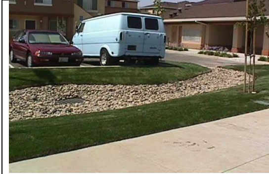
Biyo-filtre ve geçirimli döşeme uygulaması
