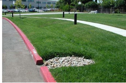
Yağmur suyu yönlendirmesi
