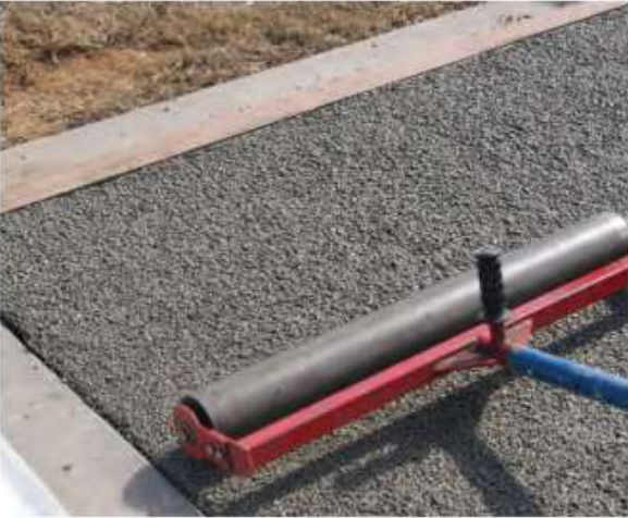
Sekil 10: Geçirimli beton kaplamaların yerleştirilmesi ve sıkıştırılması - 2
