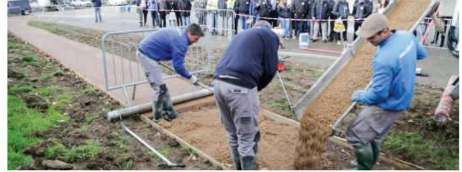
Şekil 9a: Geçirimli beton kaplamanın yerleştirilmesi ve sıkıştırılması - 1
