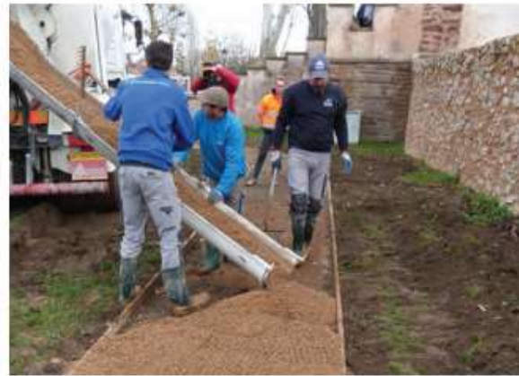
Şekil 9b: Geçirimli beton kaplamanın yerleştirilmesi ve sıkıştırılması - 1
