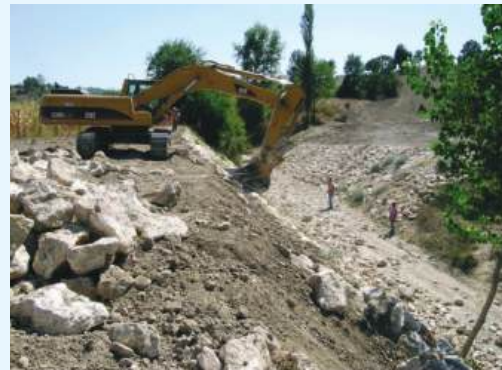
Akarsu banketinde riprap uygulaması
