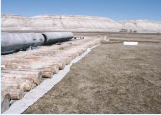
İş makinalarının ahşap platformda çalışması yoluyla akarsu ve çayır koruma
