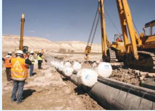
Kaynak yapılmış boruların su dolu hendekte yüzdürülerek itilmesi ve yerleştirilmesi
