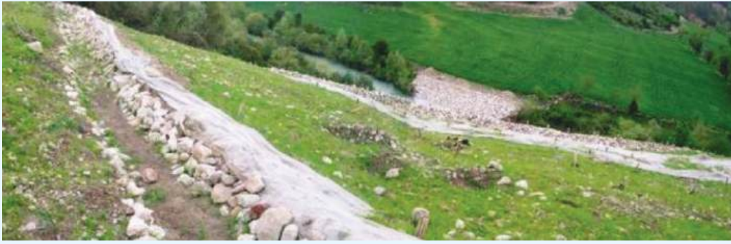
Akarsu yamaçları erozyon önleme amaçlı çimlendirme ve su kırıcı uygulaması
