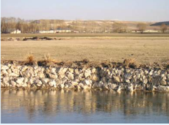
Akarsu kıyısı stabilizasyonu
