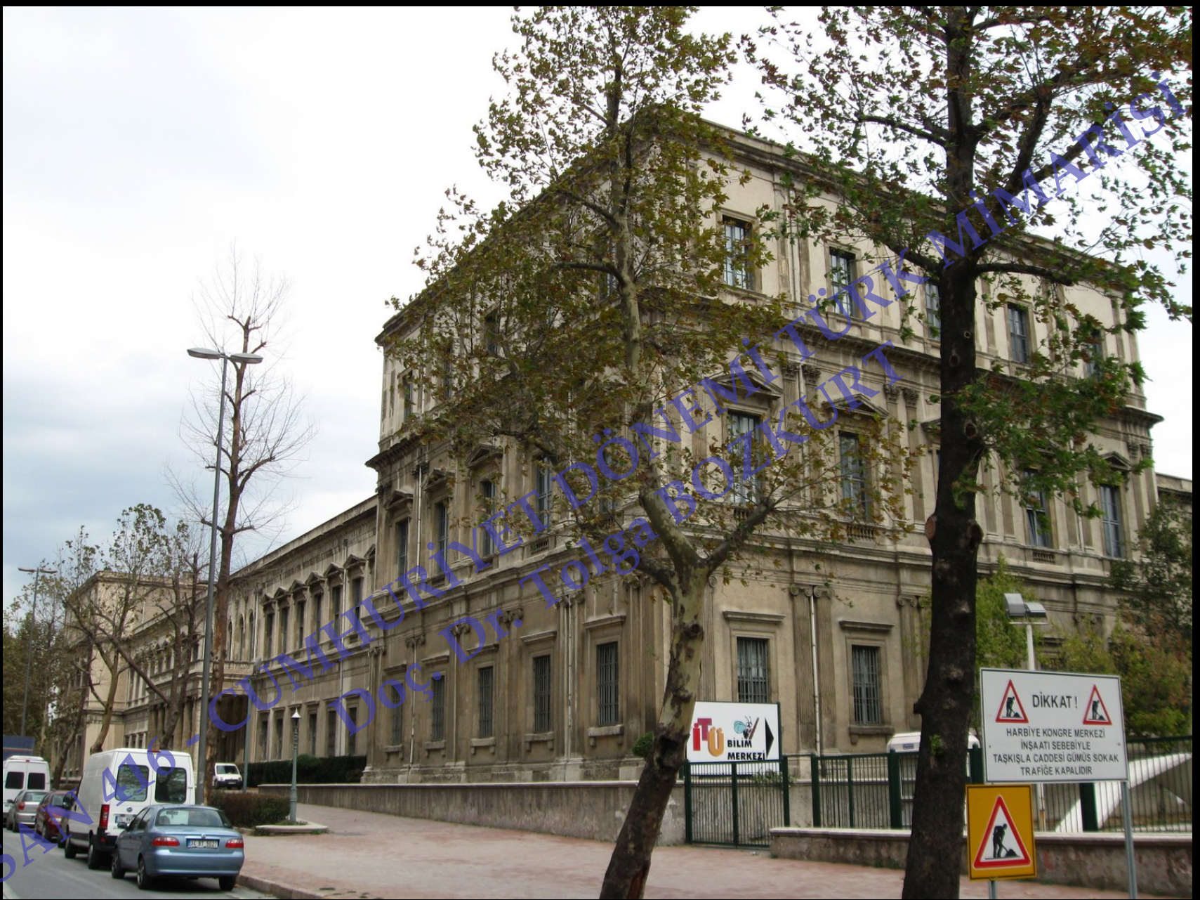
İstanbul Taşkışla (b. İTÜ Mimarlık Fakültesi), 1943-44 onarım çalışmaları, Paul Bonatz Emin Onat ile birlikte
