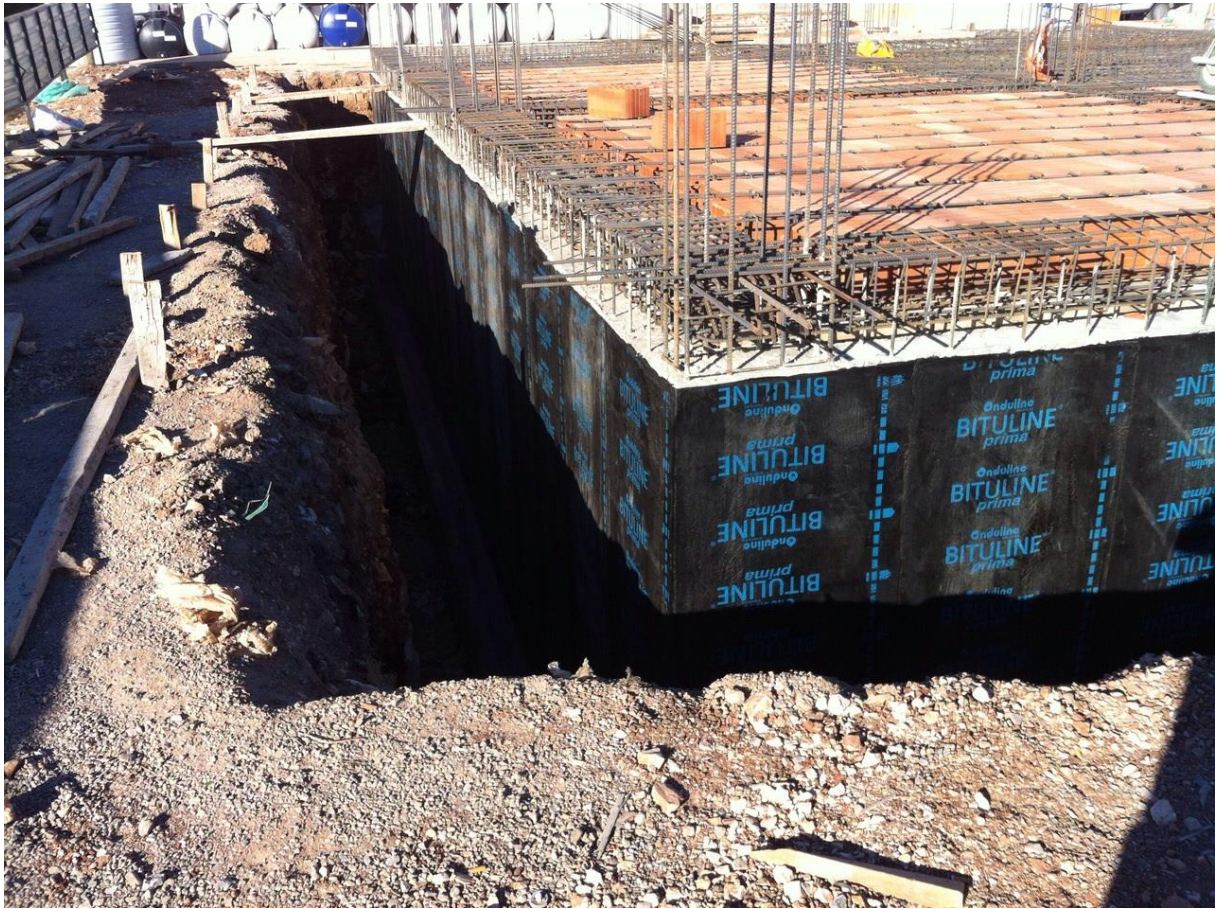
Şekil 4.1. Topraklama ile Isı ve Su Yalıtımı Çalışmaları
