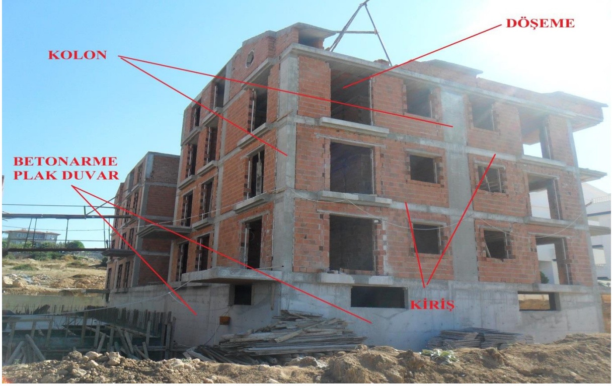
Şekil 3.2. Yapılara Ait Betonarme Taşıyıcı Elemanlar
