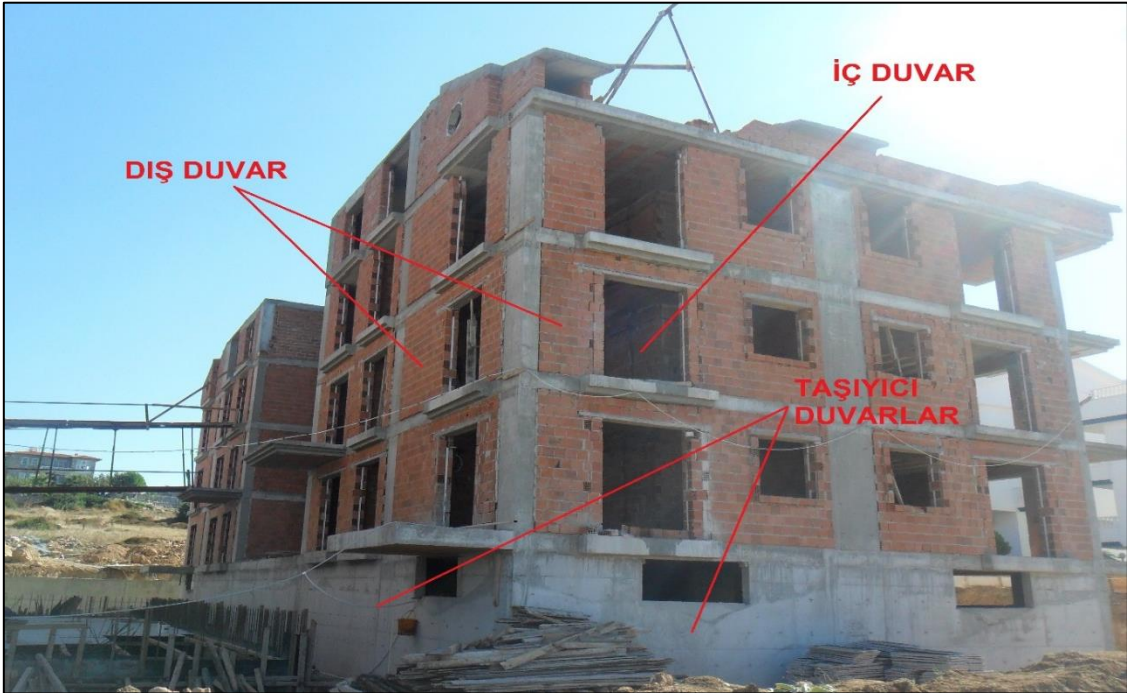
Şekil 5.2. Yapılarda Bulunan Duvar Tipleri
