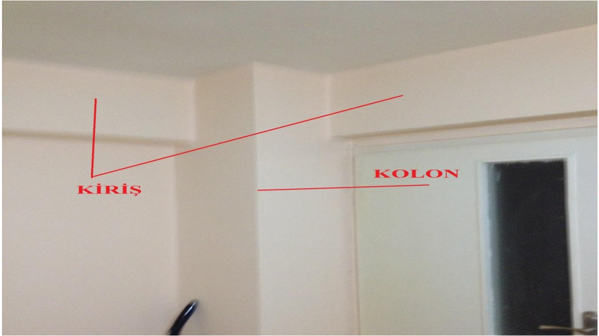
Şekil 3.1. Yapılara Ait Betonarme Kolon ve Kirişler
