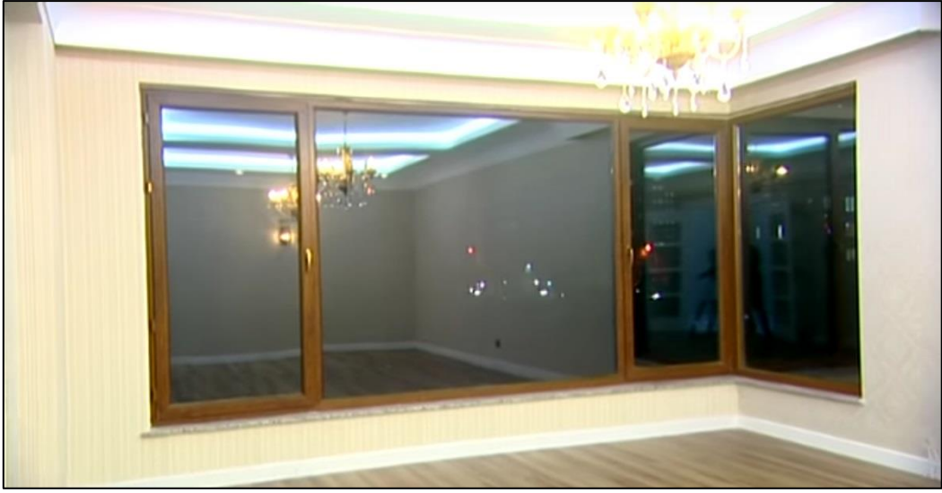
Şekil 8.1. İncelenen Yapıların Pencereleri
