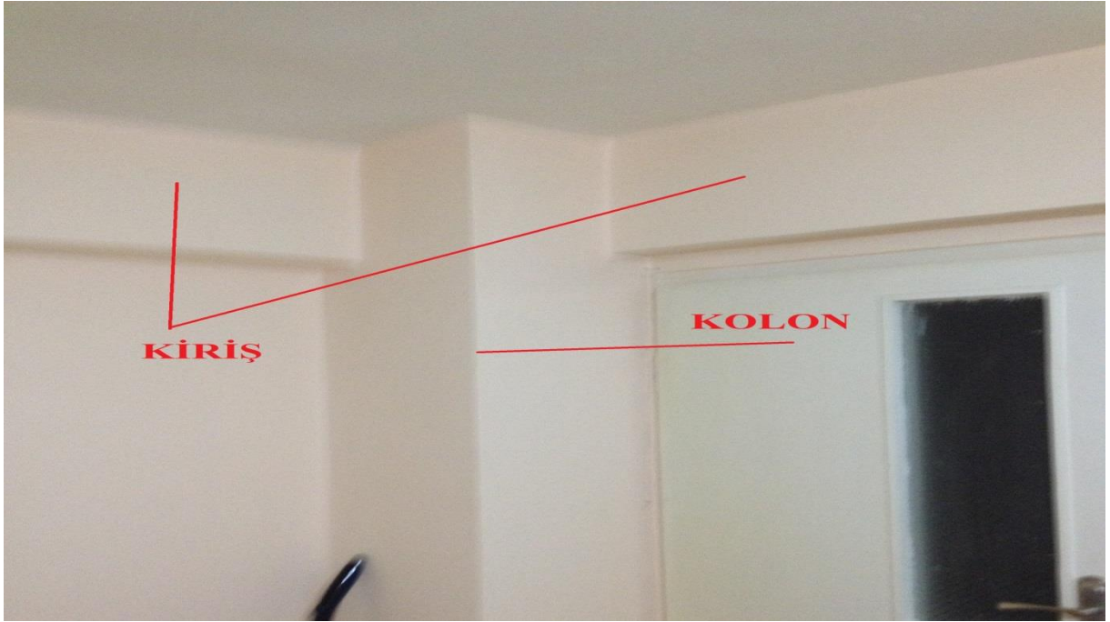
Şekil 3.1. Yapılara Ait Betonarme Kolon ve Kirişler
