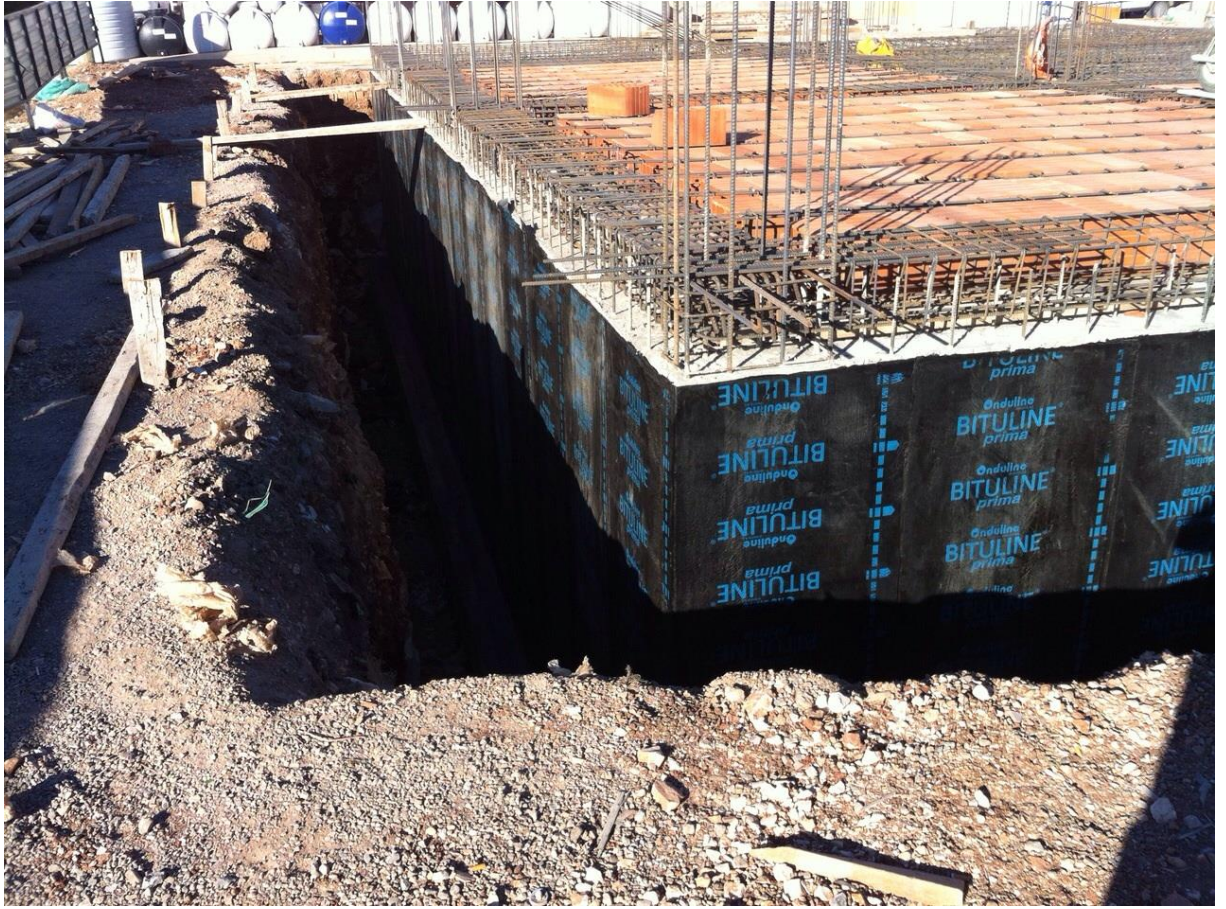
Şekil 4.1. Topraklama ile Isı ve Su Yalıtımı Çalışmaları
