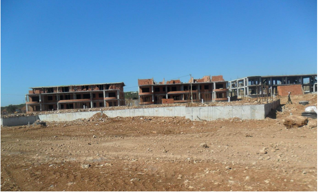
Şekil 4.2. Subasman ve Temel Yapımı Bitmiş Dolgusu Yapılmış Sürekli Temel Örneği
