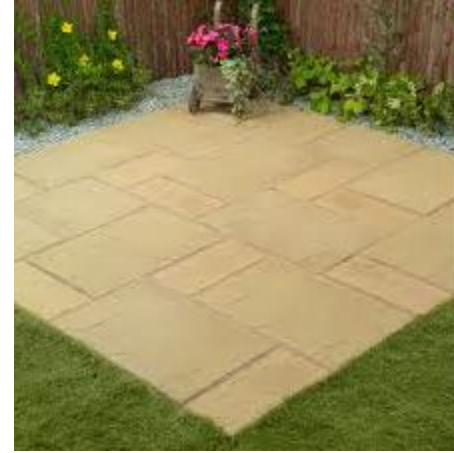
Dış mekan döşemesi
