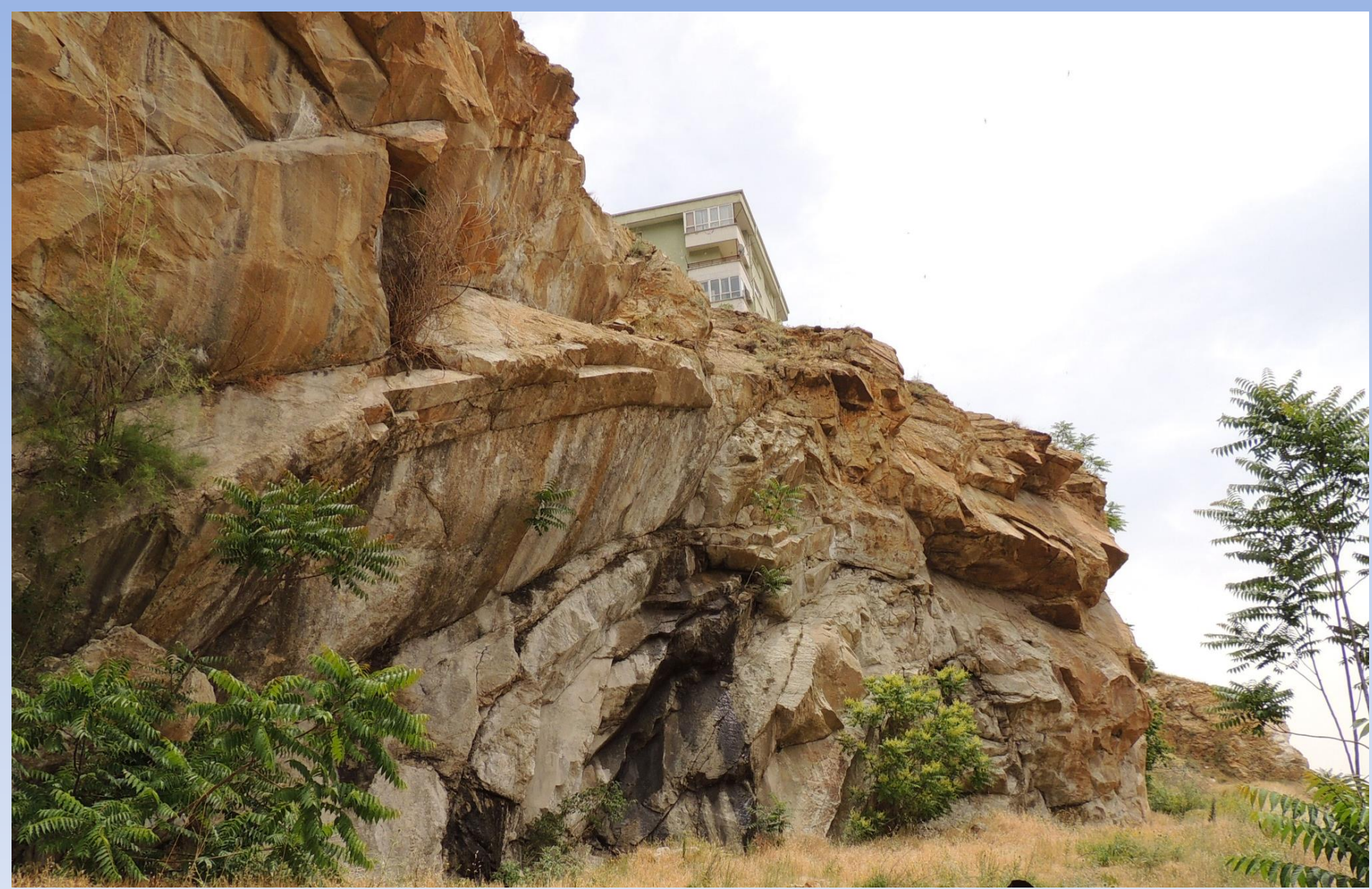
Ankara,Keçiören-Selçuklu Caddesi Eosen Dasitlerde Şev Dışına Eğimli Düzlemler
