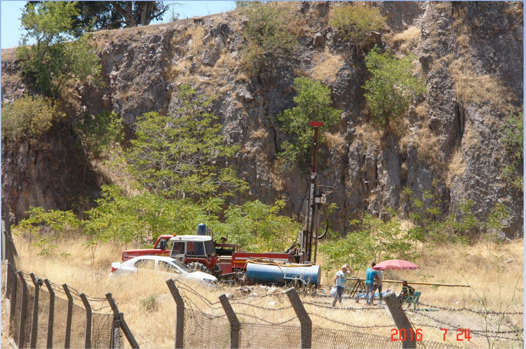
İzmir, Bayraklı Miyosen Andezit-Aglomera, Şev Düzlüğünde Temel Sondajı, Şev Eğimi Dik/Dike Yakın
