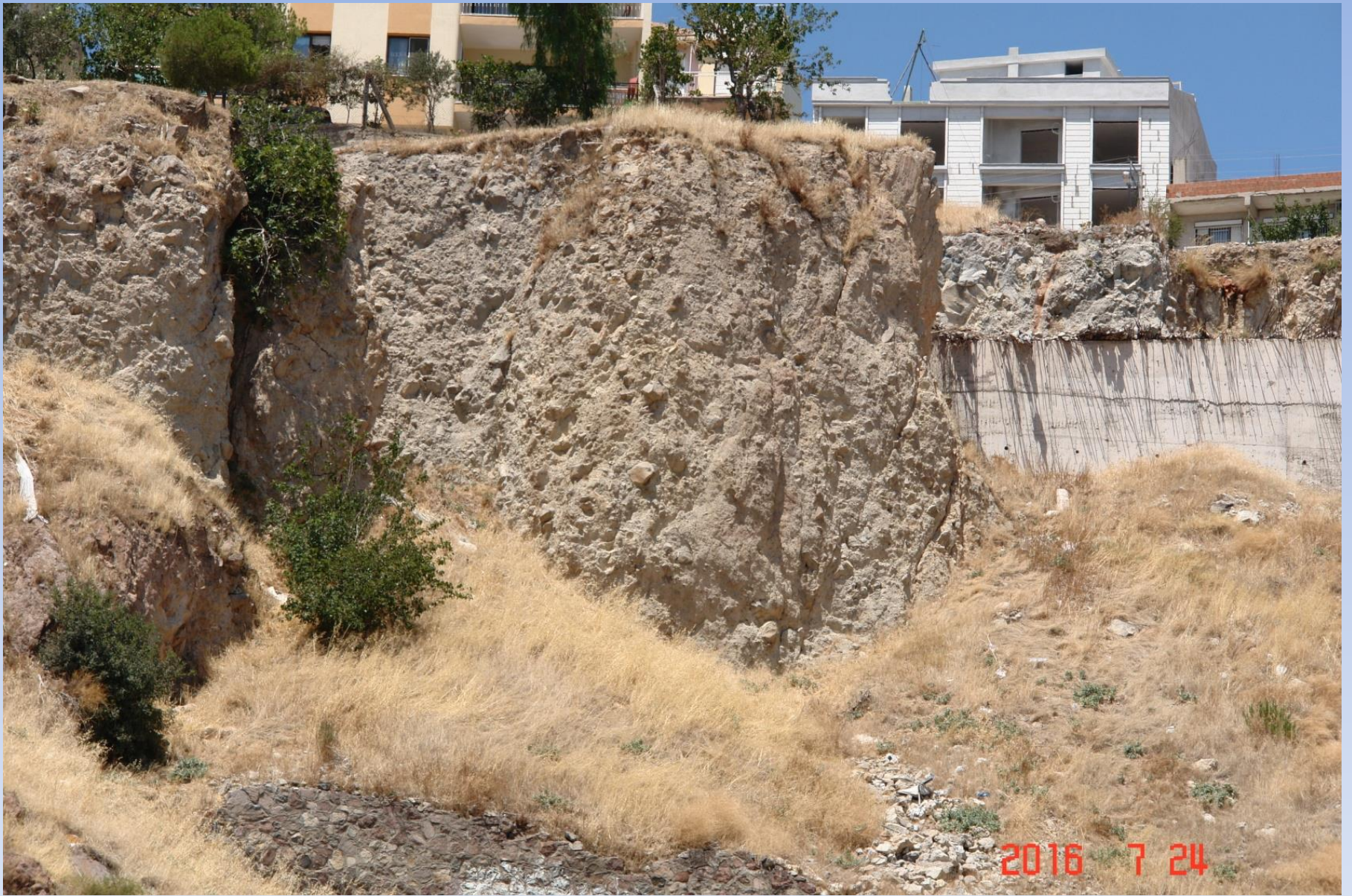
İzmir, Bayraklı Miyosen Aglomera. Kütle İçinde Farklı Ayrışmaya Bağlı Renk Tonları ve Çalışmayan İstinad Yapısı
