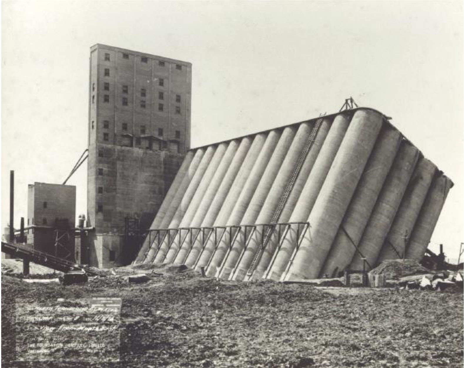
Transcosna Tahıl Ambarında Toplam 7.2 m lik Farklı oturmaya Bağlı Zemine Gömülme, 18 Ekim 1913
