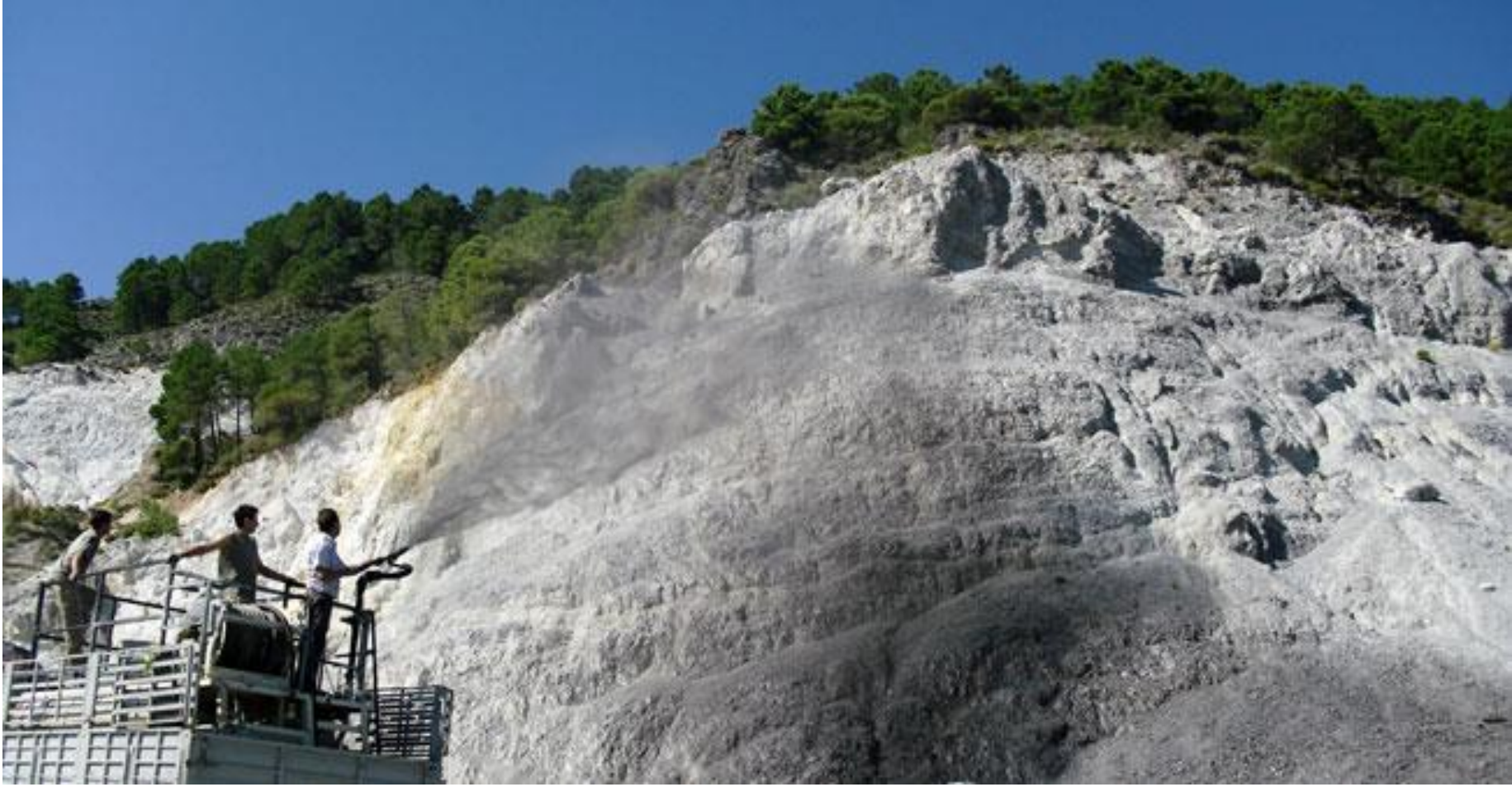
Şev yüzeyinin püskürtme beton (shotcrete) ile kaplanması
