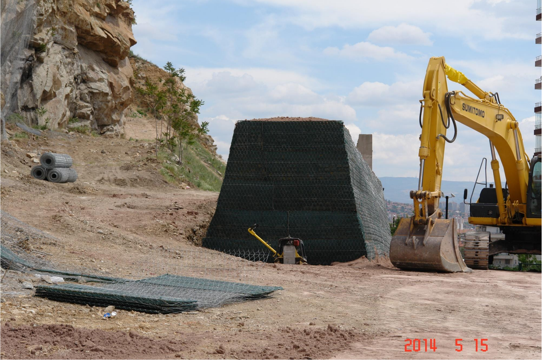
Şev topuğunun önünde donatılı toprakarme duvar imalatı (Keçiören, Ankara)
