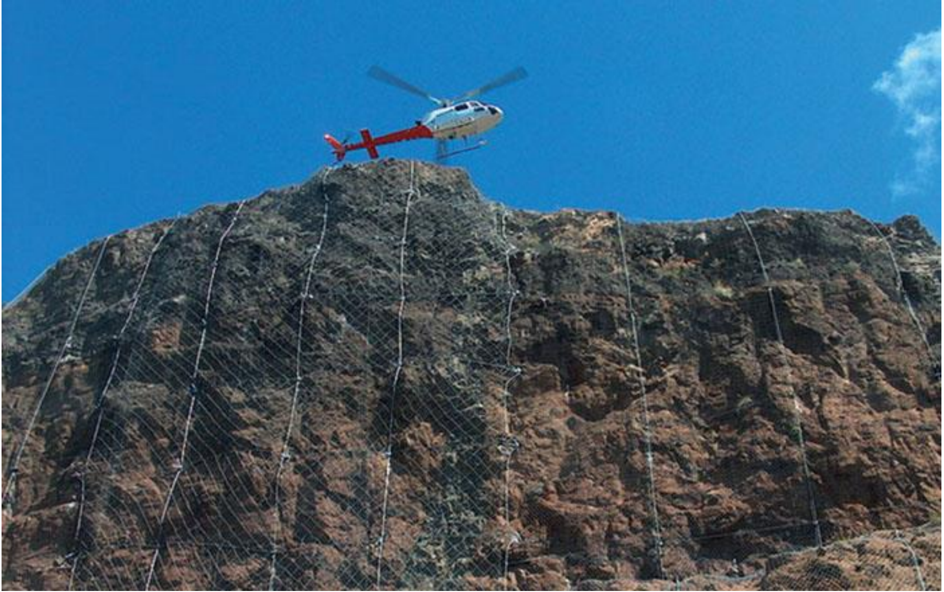
Şev yüzeyinin çelik ağ ile kaplanması
