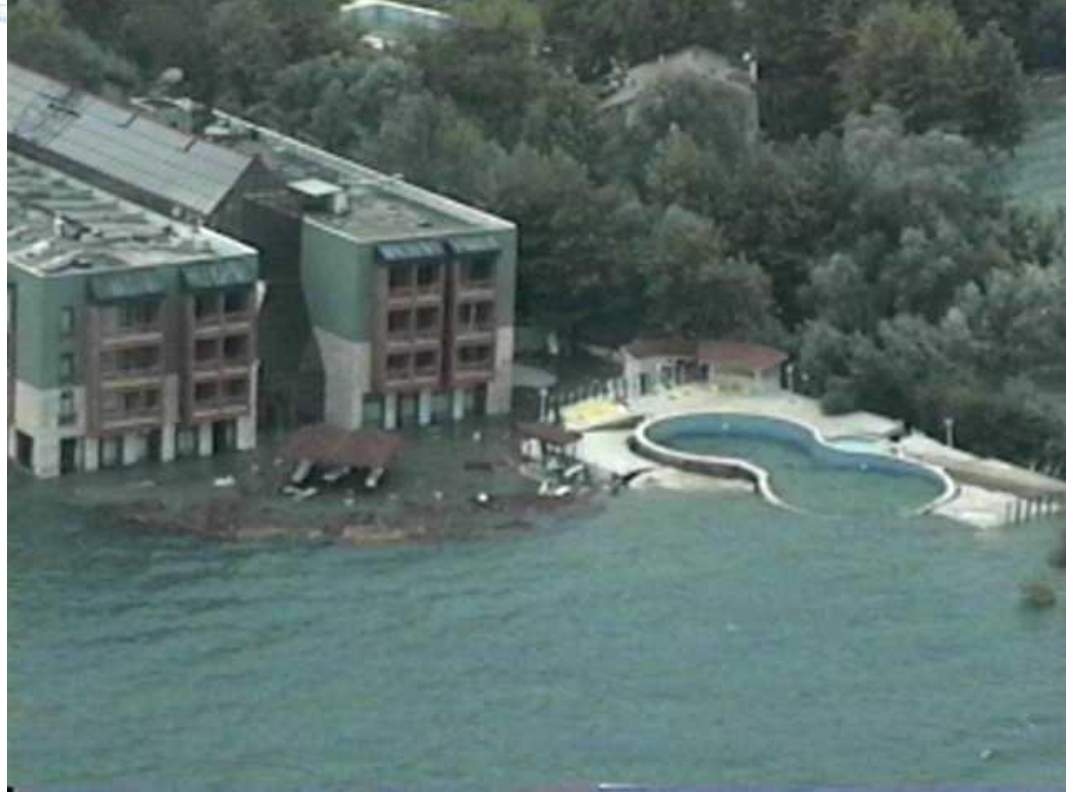
Sapanca, Yanal Yayılma, 17 Ağ. Depremi Sonrası
