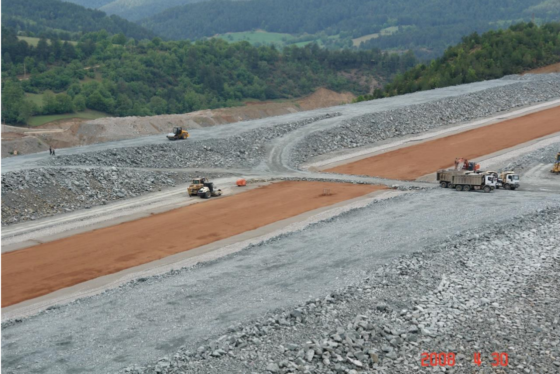
Bolu-Köprübaşı barajı Çekirdek İmalatı
