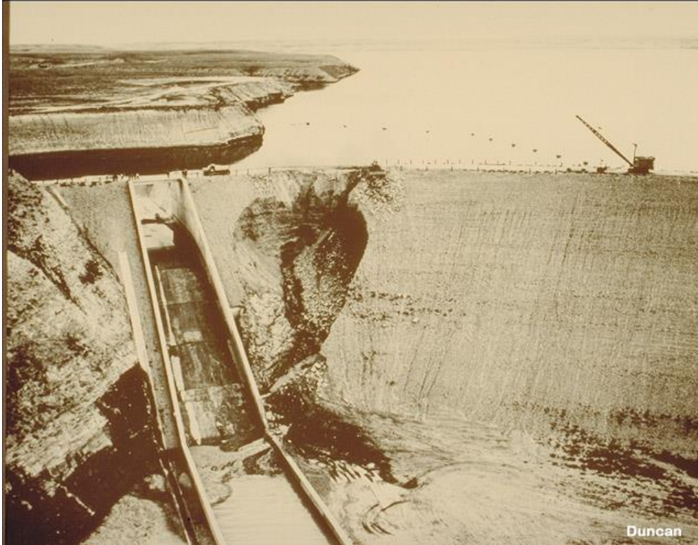
Baldwin Hills Barajı, borulanma yenilmesi (1963)
