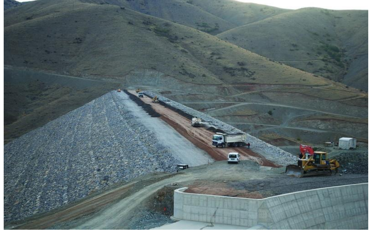
Malatya-Kapıkaya barajı Çekirdek İmalatı ve Rip-rap görüntüsü
