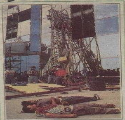
22. KATTAN DÜŞTÜLER Ataköy'de 25 katlı Crown Plaza Oteli inşaatının üç cephesi ise camlarının baskı işlemleri ni yapıyor. İnşaatçı, 22. kattan büyük bir çöküşle beton zemine çakıldı. Ercan AKYILDIZ'ın kuzey 18. SİFIRAK
