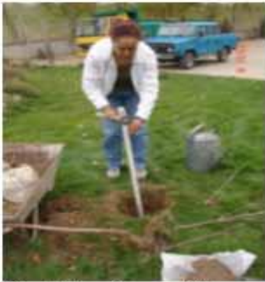
Destek kazığının sabitlenmesi
