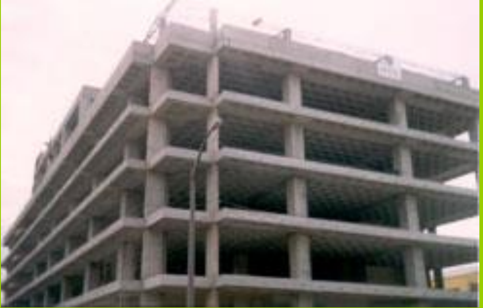
betonarme iskelet yapı
