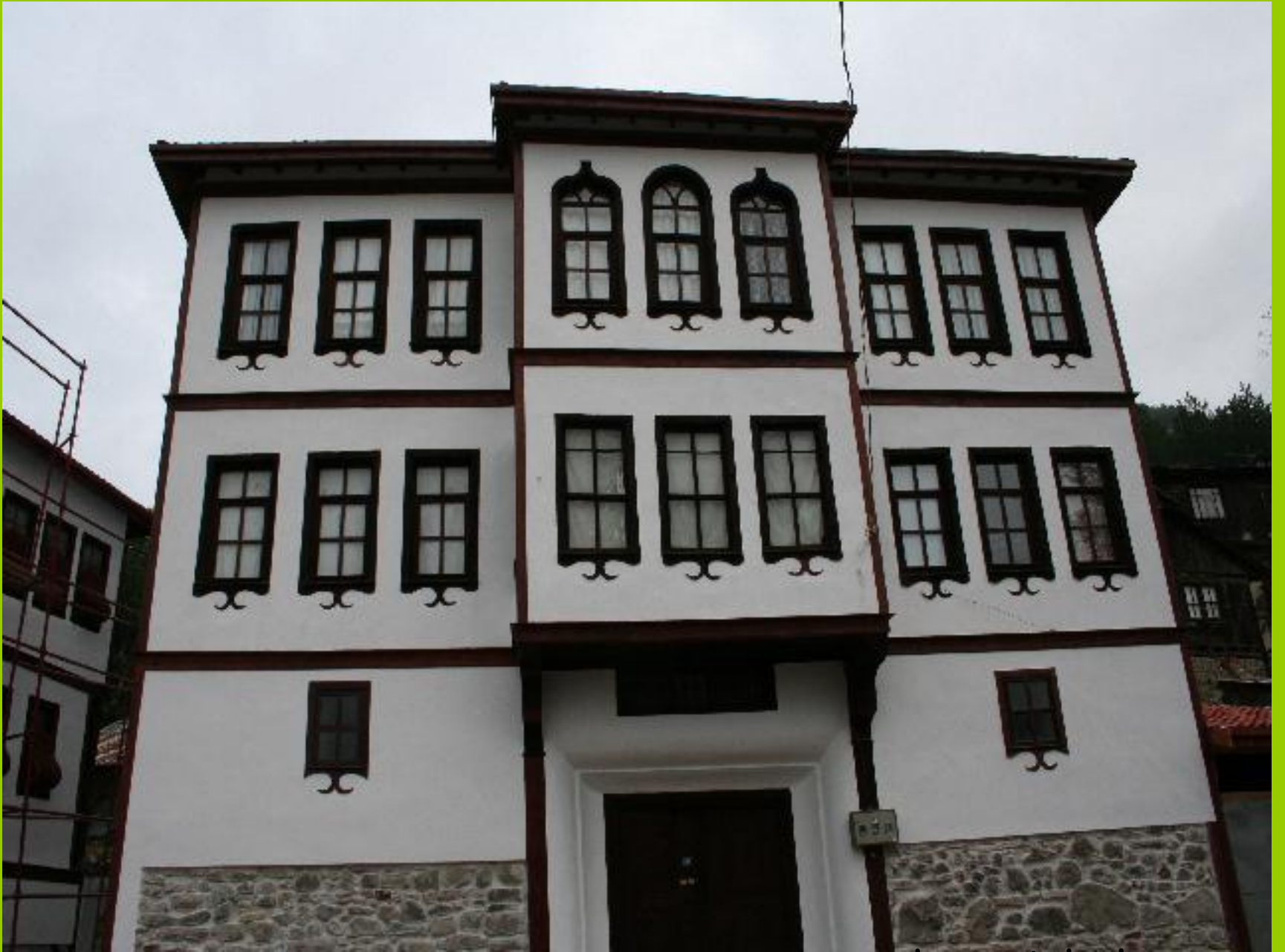
ahşap iskelet yapı
