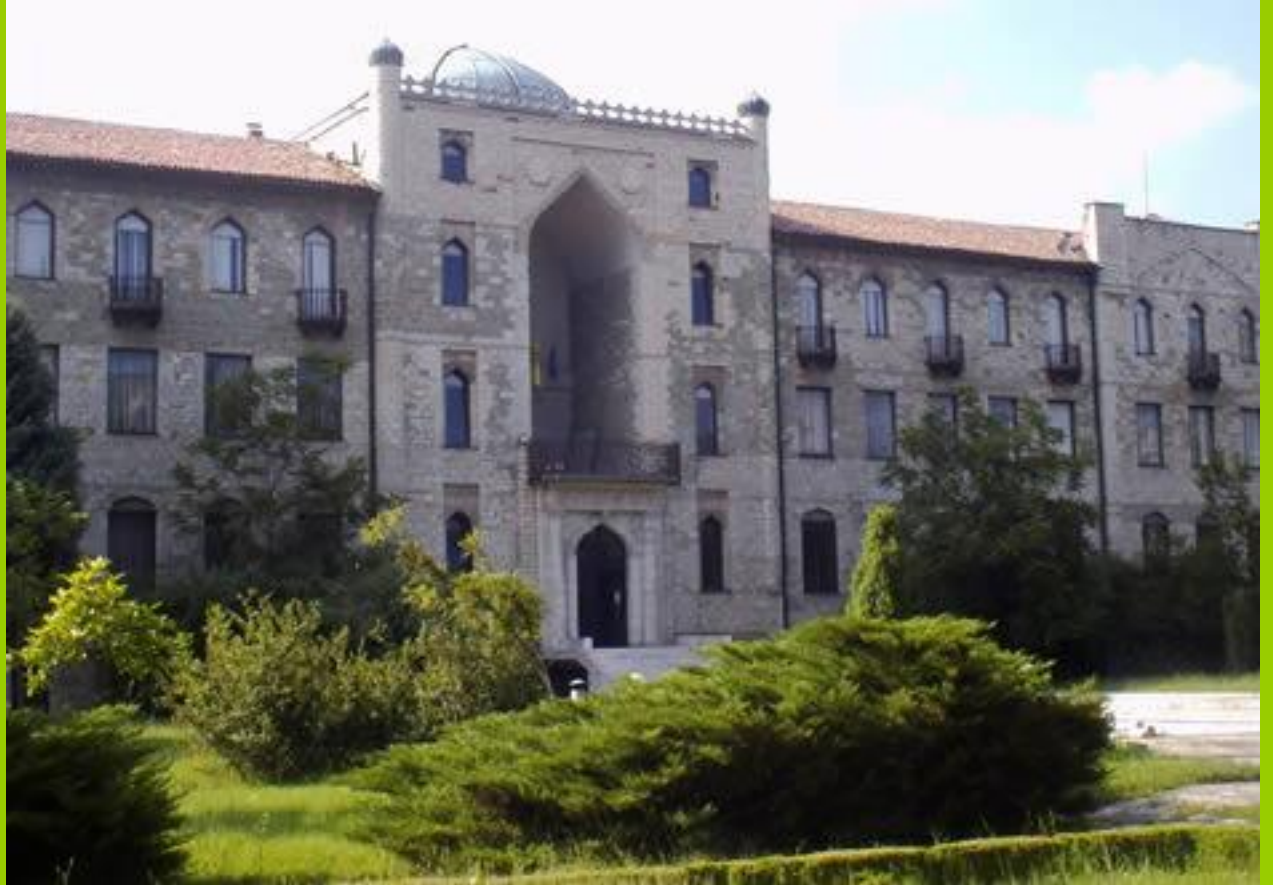
yığma taş yapılar
