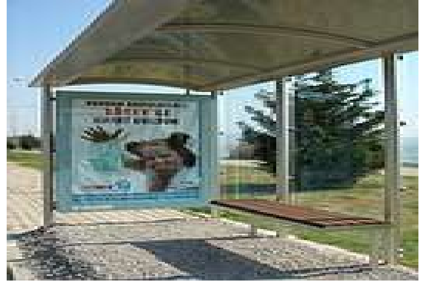
Polikarbonat malzemedен yapılmış otobüs durağı
