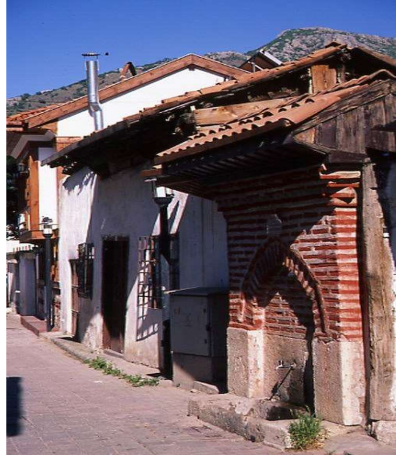
Beton ve tuğla karışımı çeşme
