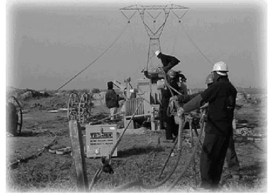
Resim 2.2: Yüksek gerilim havai enerji hattında iletken çekilmesine ilişkin çalışmalar.
