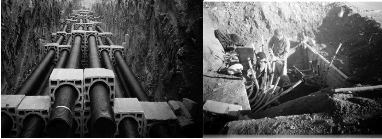
Resim 2.1: Yer altı enerji hattının çekilmesine ilişkin çalışmalar.
