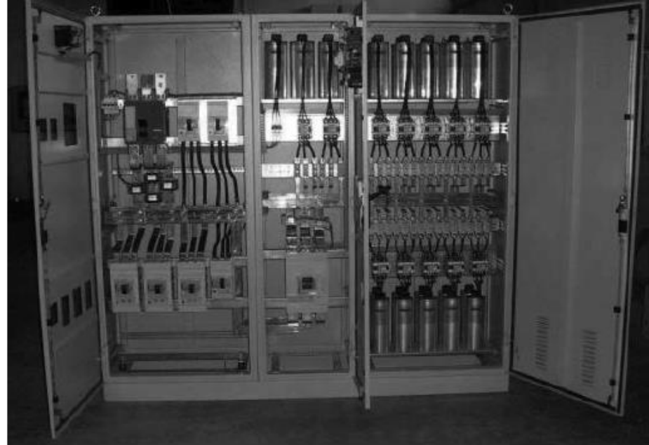
Resim 6.6: Alçak gerilimde kullanılan kompanzasyon panosu.
