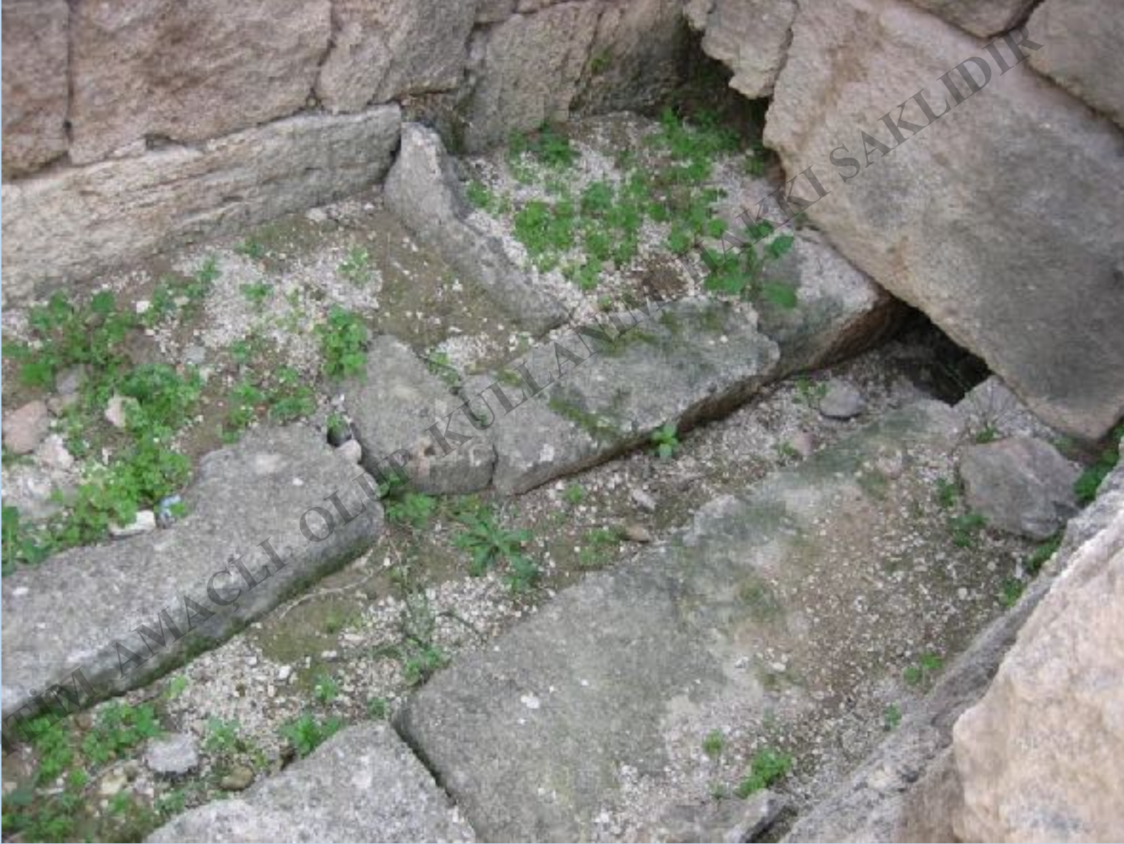
Su Arıtma Sistemi
