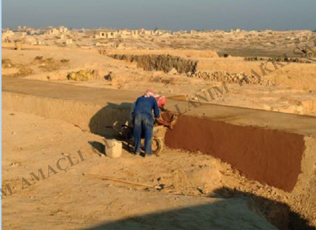
Bakım ve onarım çalışmaları
