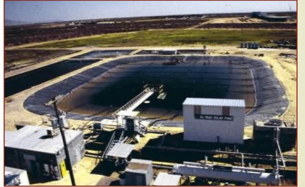
Şekil 4.15 Güneş havuzu ( http://www.limitsizenerji.com/haberler/makaleler/1120-gunes-havuzlari )
