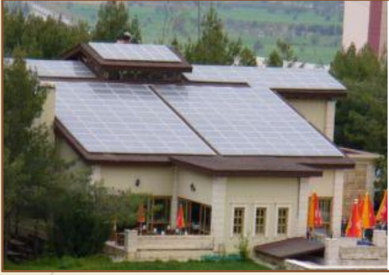
Türkiye'de ilk binaya entegre fotovoltaik sistem uygulaması Muğla üniversite yerleşkesi (25.6 kW) (2001) (DPT)
