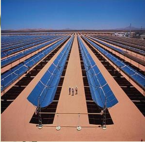
Şekil 4.23 Parabolik oluk kolektör santrali ve şematik gösterimi (Anonim, 2012b)
