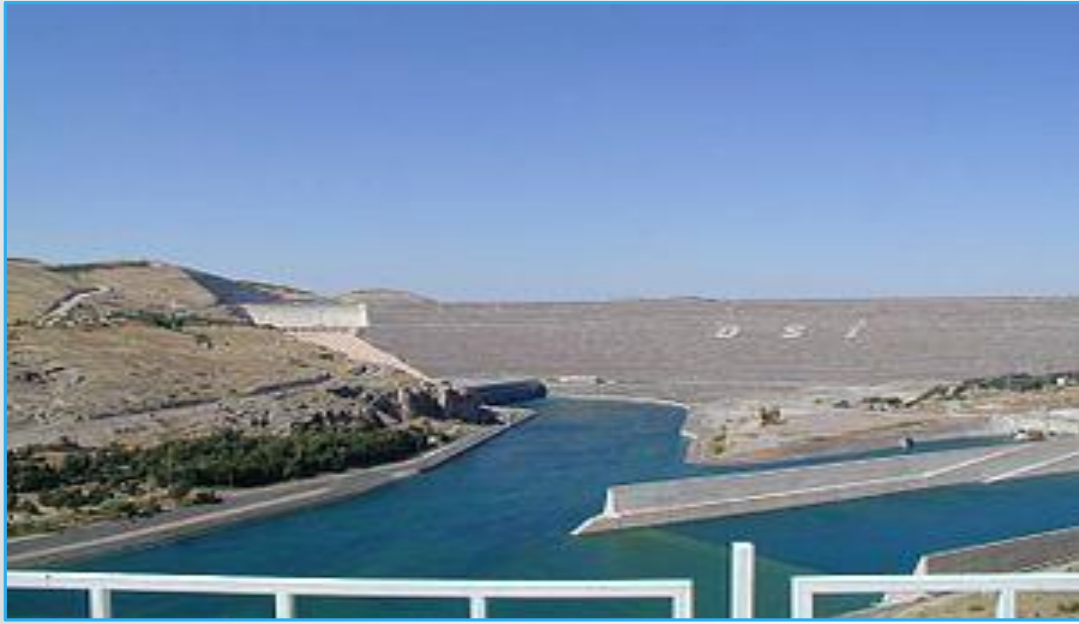
Atatürk Barajı-Türkiye -2400 MW
