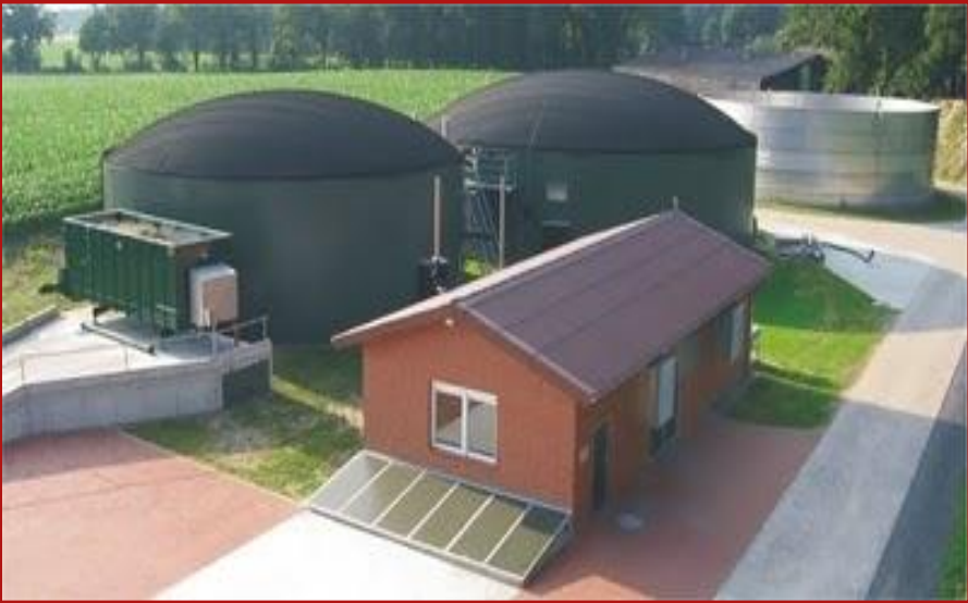
Şekil 10.21 Aile tipi biyogaz tesisi ( http://emreecce.com/yesil-enerji-biyogaz/ )
