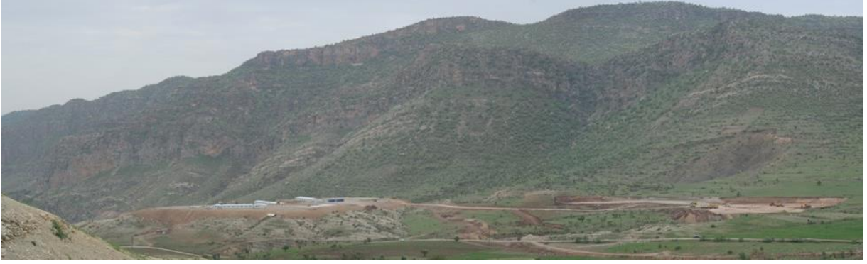
Şekil 13: Batı-doğu hattı eksen yolu (yukarıdaki resim) ve geçici yol, şantiyeler ile kireç taşı malzeme alım yeri (aşağıdaki resim)
