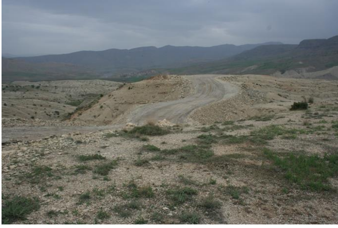
Şekil 15: Batıdan baraj eksenine doğru bağlantı yolu
