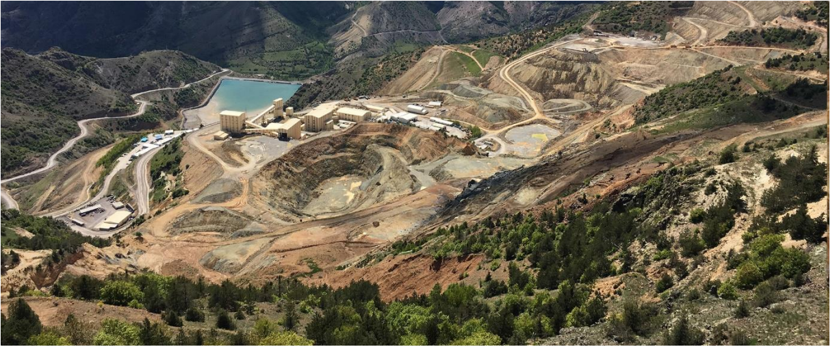
Resim 4. Gümüşhane-Mastra Altın İşletme Sahası Genel Görünüşü ( www.kozaaltin.com.tr )
