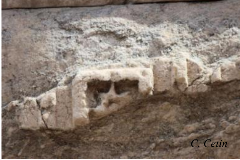
Resim 6. Ankara Augustus Tapınağı mermer yapı elemanında atmosferik bozulma sonucunda oluşan tahribat. (C.Çetin, Ankara 2015)
