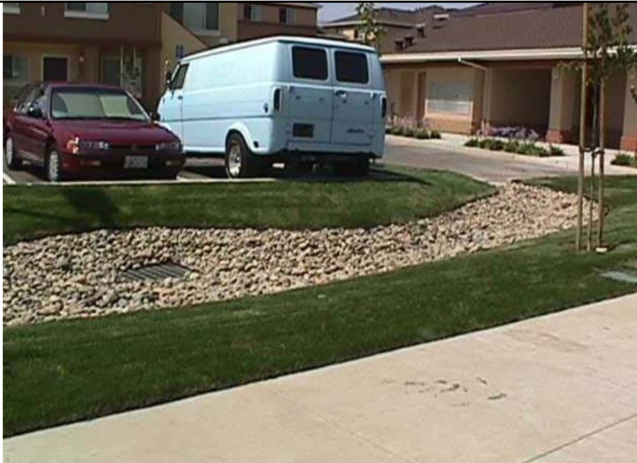
Biyo-filtre ve geçirimli döşeme uygulaması
