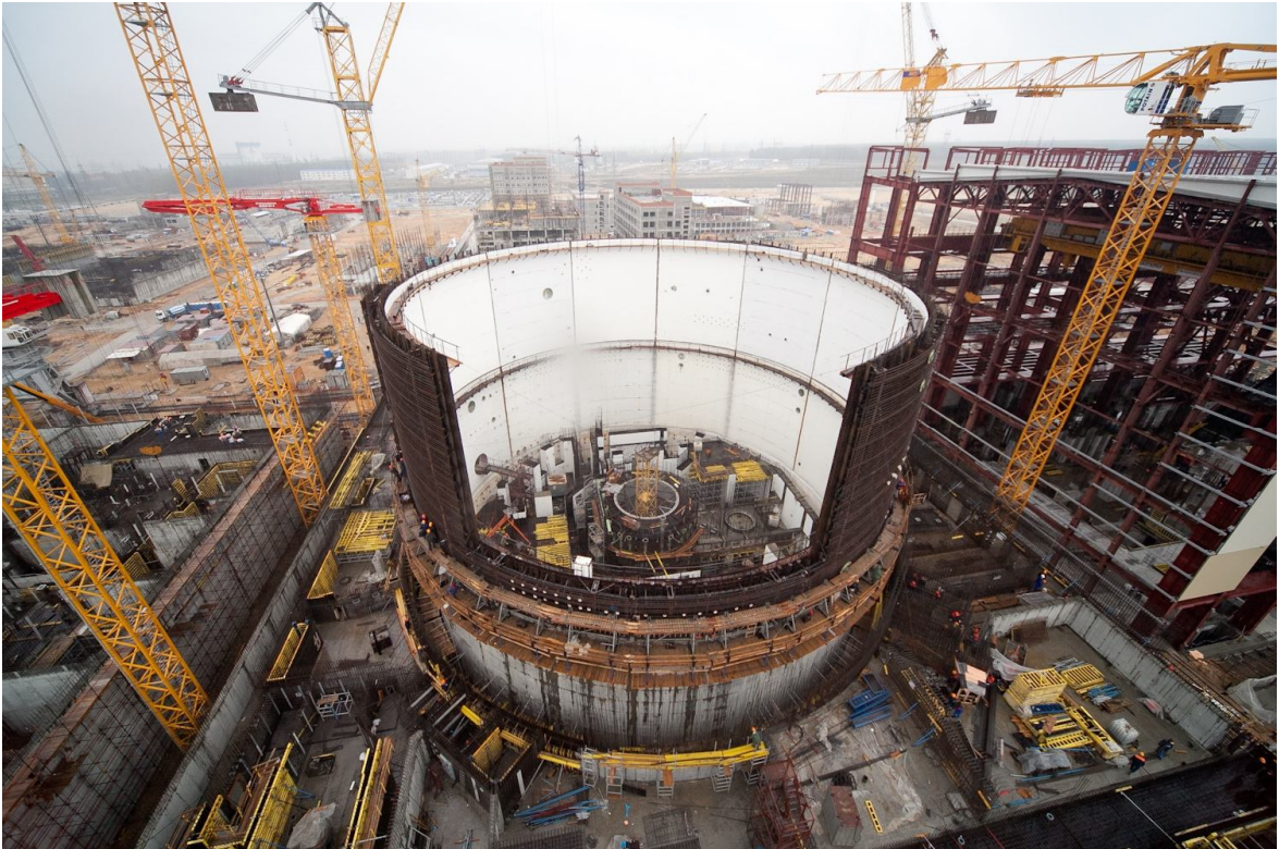
Şekil 1-9 NVNPP-2 NGS İnşaatı (Rusya) Kaynak: WorleyParsons, 2011
