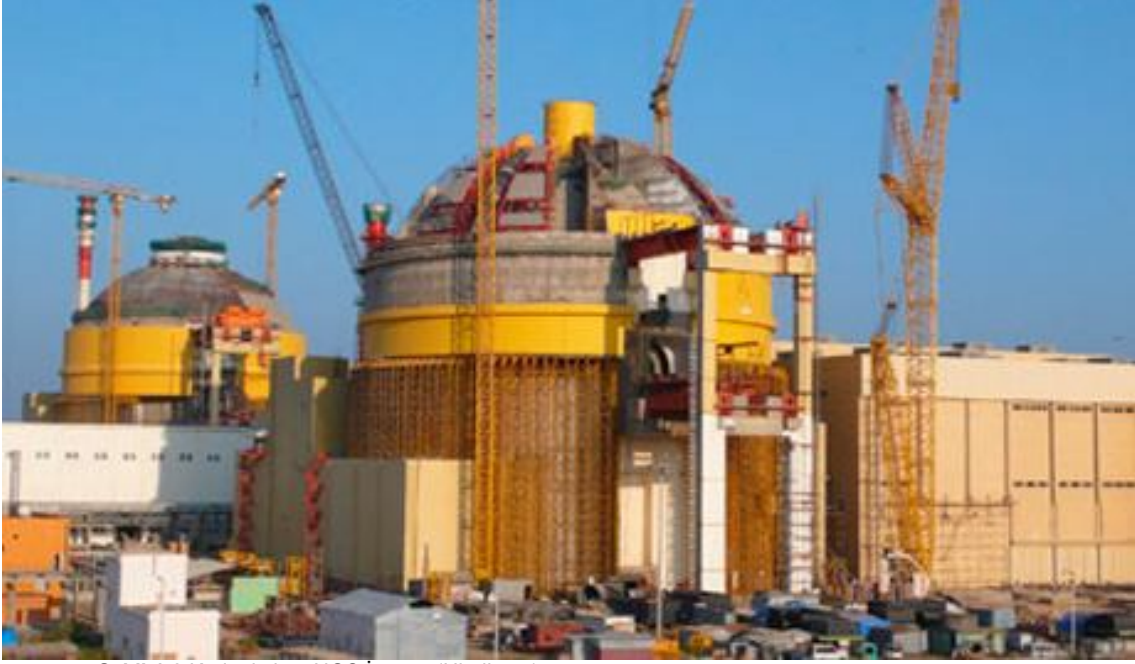
Şekil 1-8 Kudankulam NGS İnşaatı (Hindistan) Kaynak: WorleyParsons, 2011
