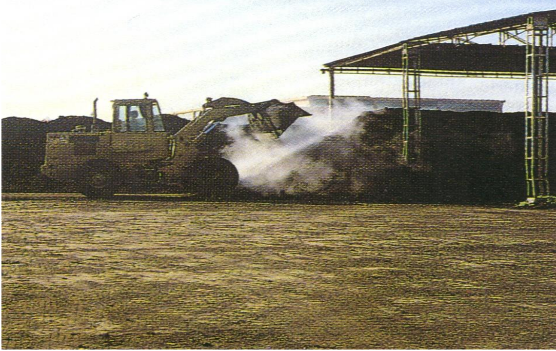
Şekil 6. Ön karıştırma sahasında hayvanların altından alınan gübrelerin toplanması
