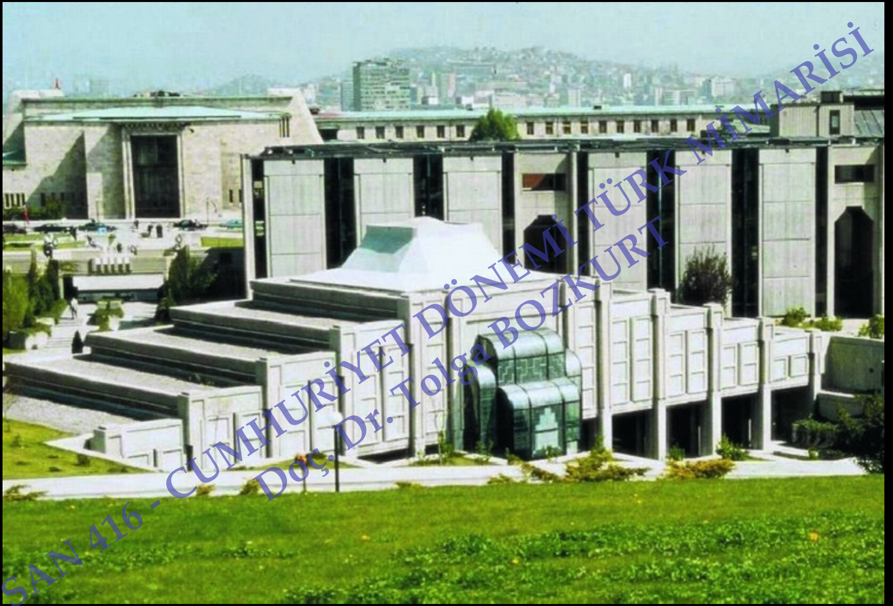
TBMM Cami Kompleksi 1990- 1992 Ankara Mimari tasarım: Behruz Çinici , Can Çinici
