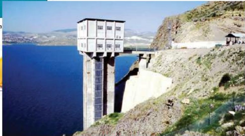
Çamlıdere Barajı Su alma yapısı
